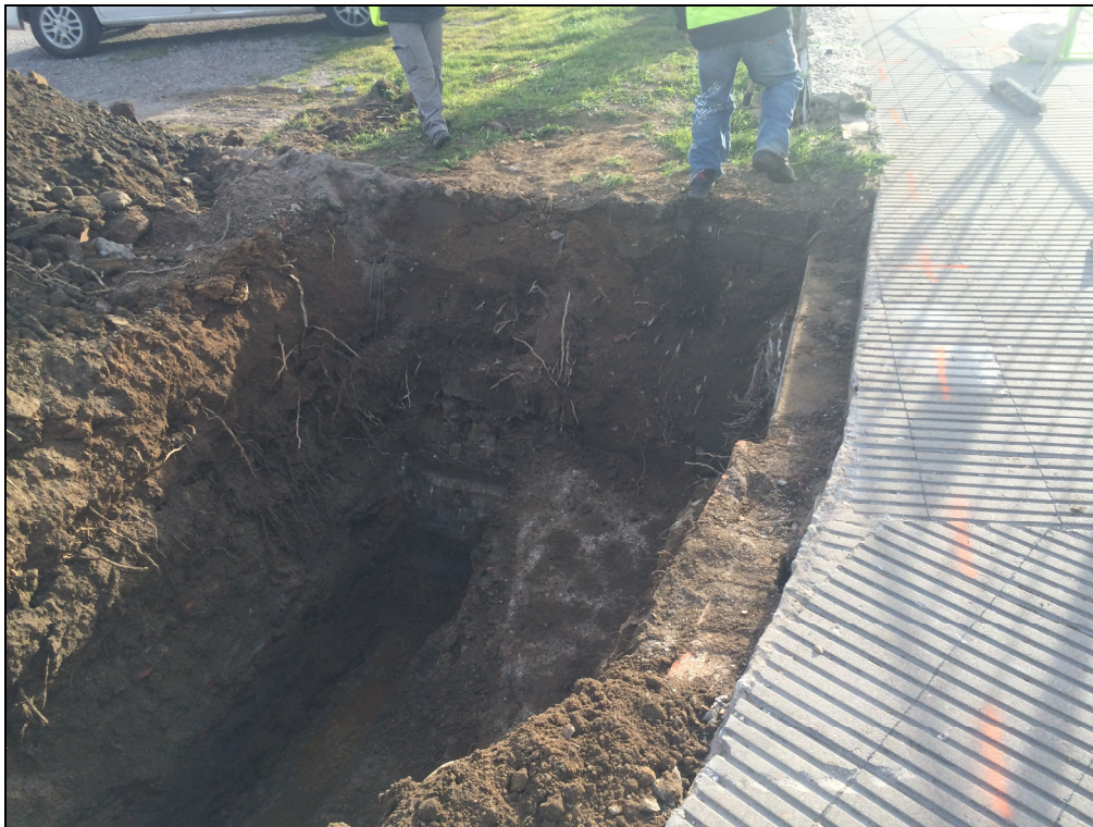
Fig. 23.- Vista del sondeig un cop finalitzat. S'observen amortitzacions de terres entre les restes de serveis i pavimentacions relacionats amb l'illa d'habitatges existents a la zona.
