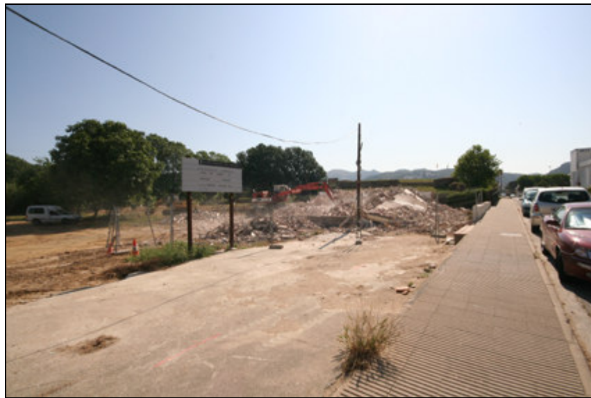
Fig. 13.- Imatge de l'enderroc dels habitatges existents a la zona.
