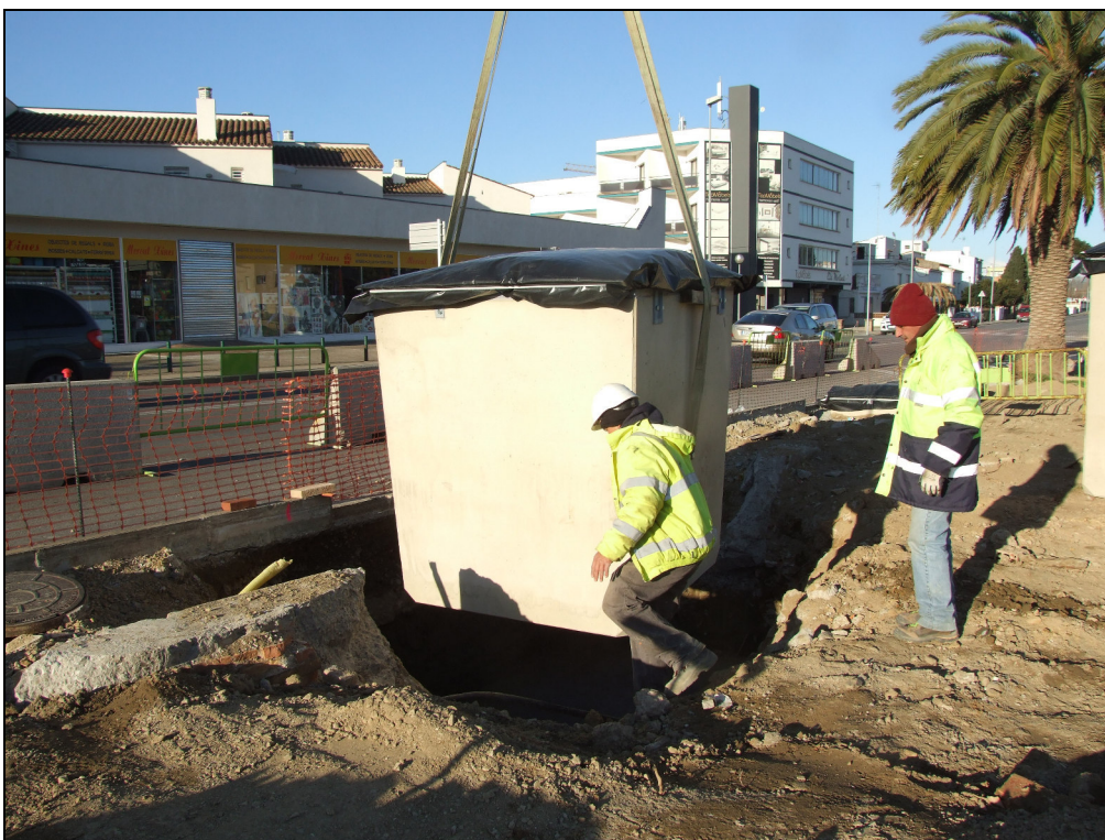
Fig. 30.- Detall de les tasques de col·locació de les caixes de formigó a l'interior dels sondejos excavats.
