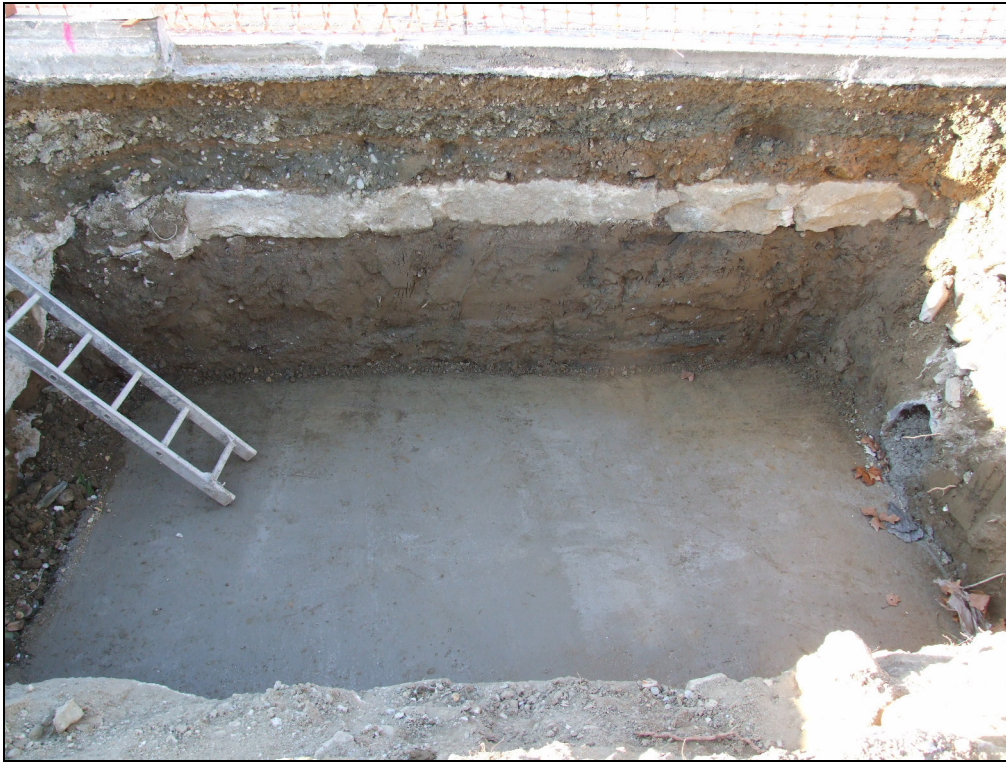
Fig. 25.- Vista del segon sondeig realitzat. S'observa al perfil la línia de pavimentació antiga corresponent a laavinguda de Rhode. Construïda sobre nivells de terra naturals sense restes antròpiques al seu interior.
