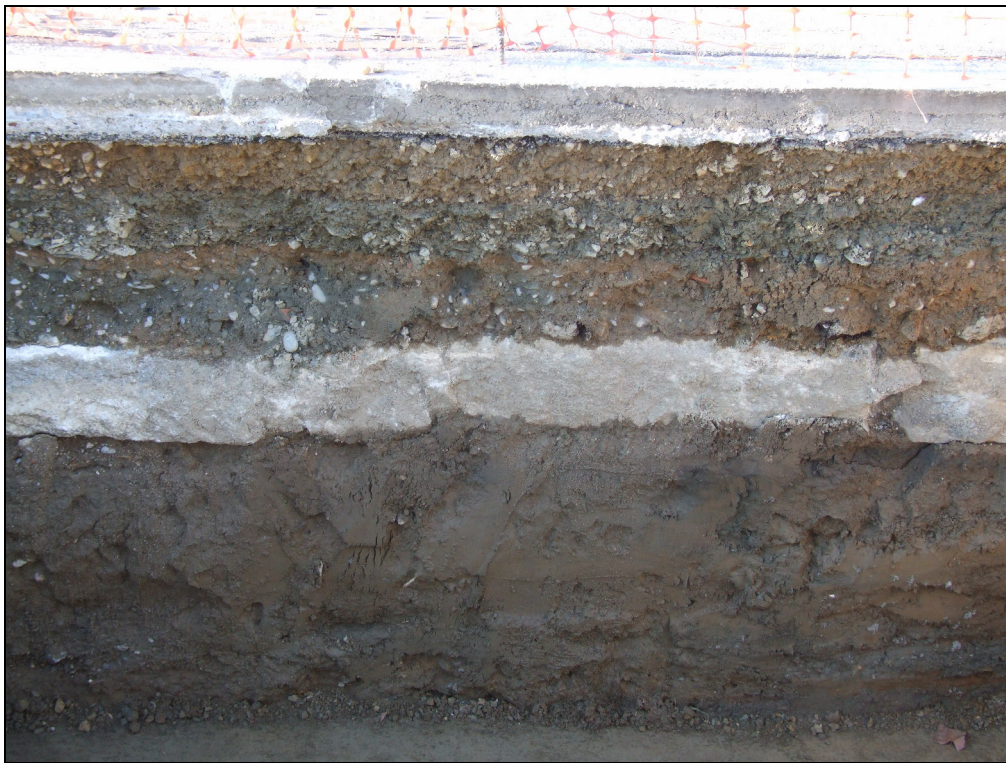
Fig. 26.- Detall de la línia de pavimentació localitzada al sondeig 2.
