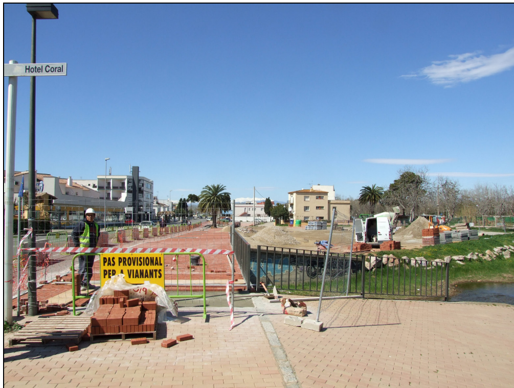
Fig. 31.- Vista de la franja on s'han col·locat els contenidors soterrats un cop realitzada la reposició de la nova pavimentació.
