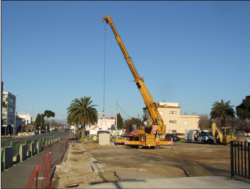
Fig. 29.- Vistes de les tasques de col·locació de les caixes de formigó a l'interior dels sondejos excavats.
