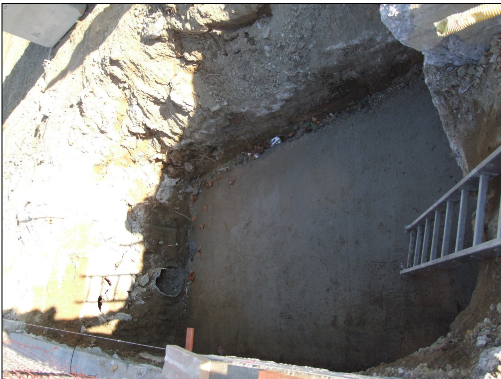
Fig. 28.- Vista del tercer realitzat un cop finalitzada la seva excavació.
