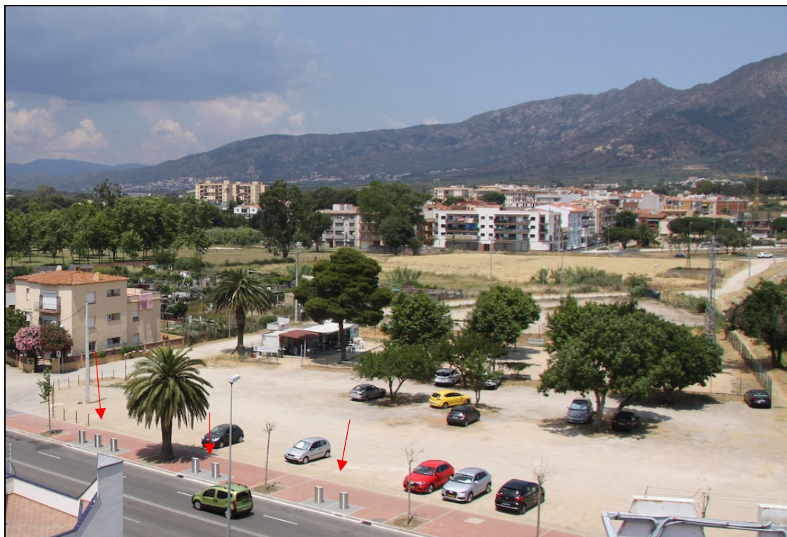
Fig. 17.- Vista de la ubicació on s'ha soterrat la illa de contenidors.
