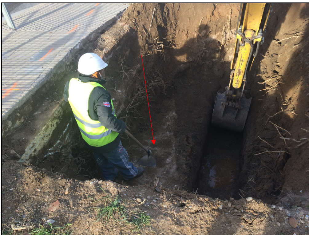
Fig. 22.- Localització per sota de la capa d'amortització de terres d'una línia de serveis existent.
