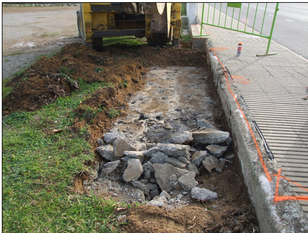
Fig. 20.- Vista de les tasques de picatge de la capa de formigó localitzada.
