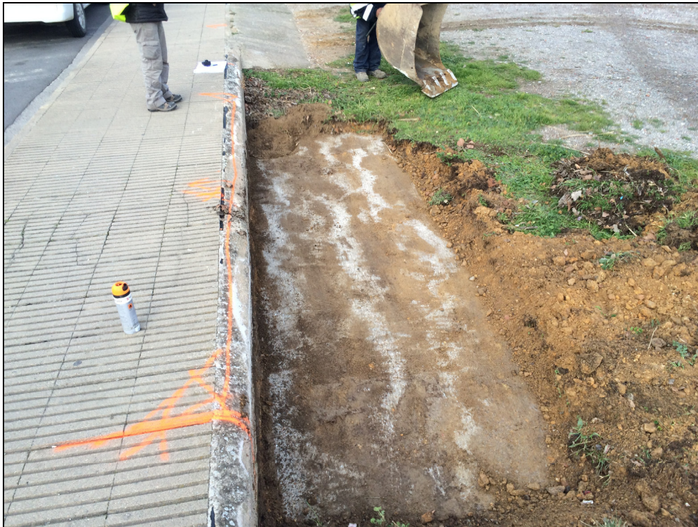
Fig. 19.- Capa de formigó localitzada sota el nivell superficial actual i relacionada amb el nivell de pas de la zona d'habitatges enderrocats a la zona.
