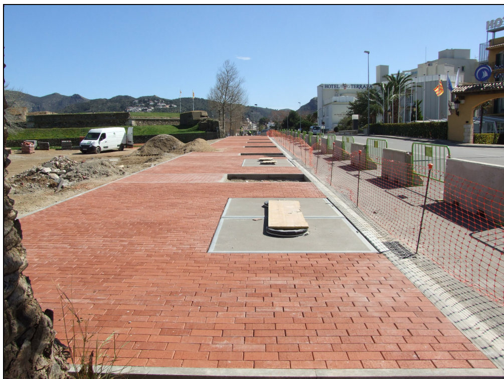
Fig. 32.- Vista de la franja on s'han col·locat els contenidors soterrats un cop realitzada la reposició de la nova pavimentació.
