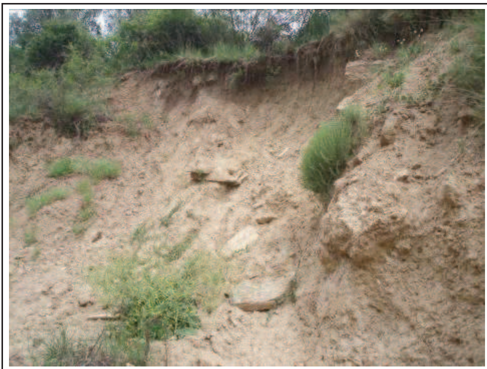
Foto 3: talús del paratge de Rebollar a l'indret conegut amb el topònim de la Creu, on s'ha dut a terme d'intervenció.
