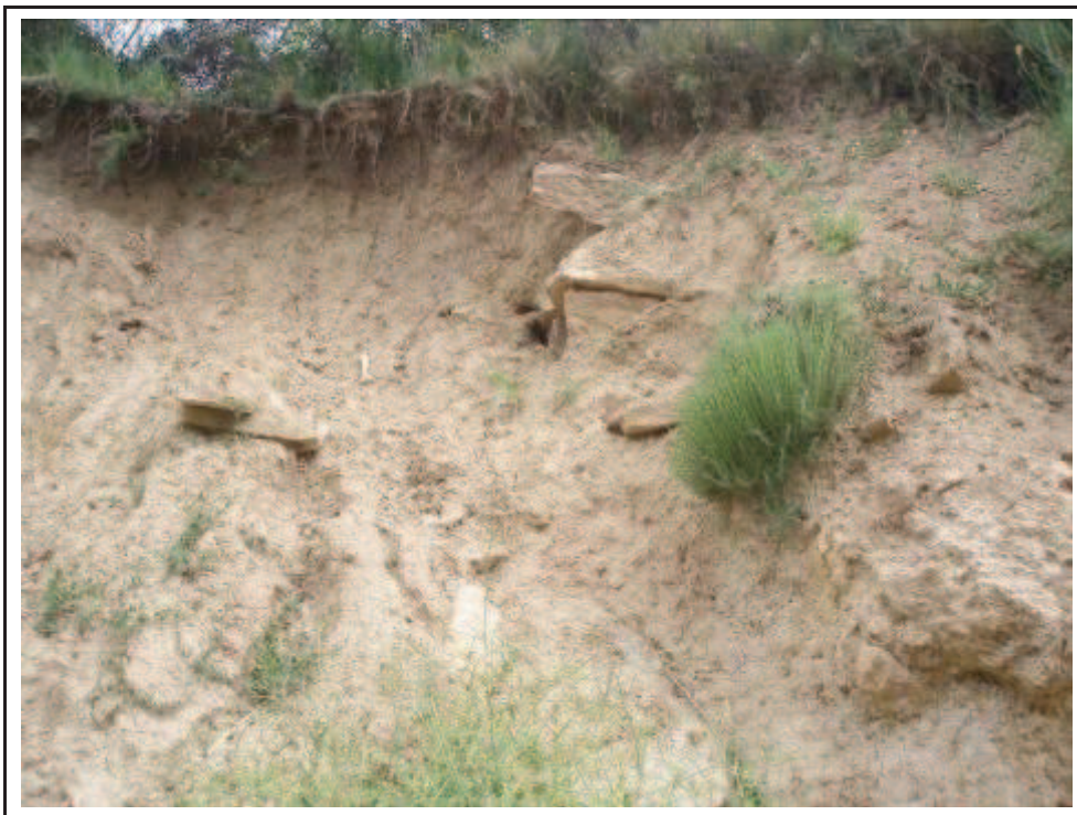
Foto 2: talús del paratge de Rebollar a l'indret conegut amb el topònim de la Creu, on s'ha dut a terme d'intervenció.
