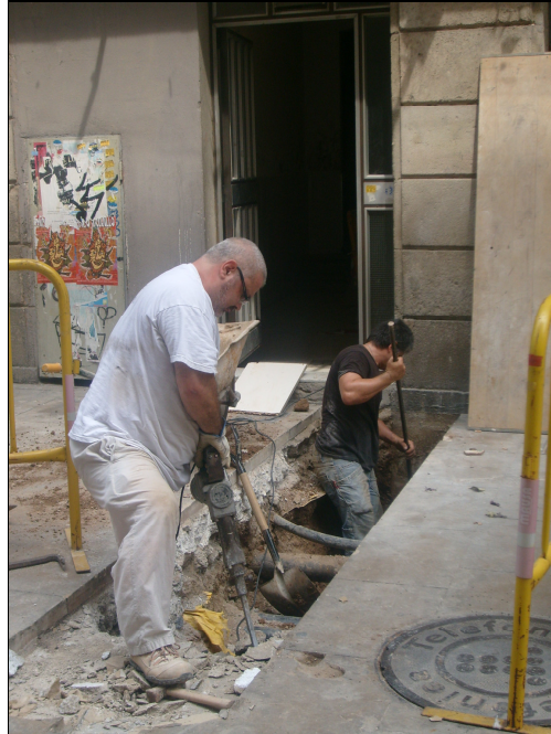
Treballadors de l'obra picant el paviment del carrer amb martell pneumàtic
