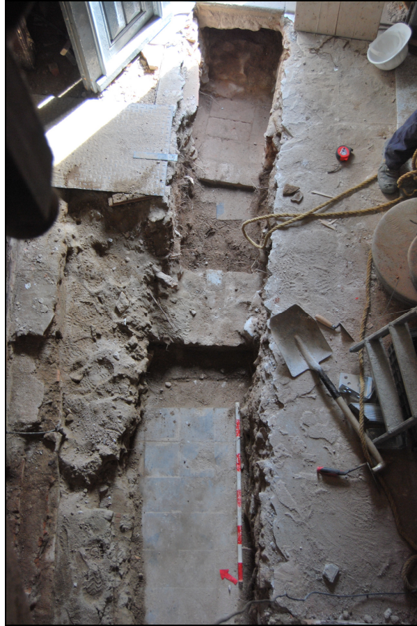
Vista general de la rasa (UE: 200) ja finalitzada
