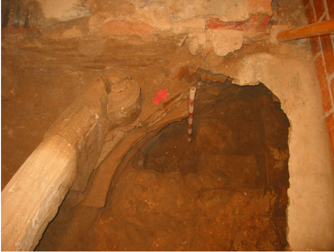
Detall de l'estructura U.E. 510.
