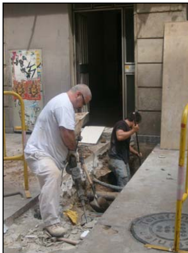
Fotografia 21. Treballadors de l'obra picant el paviment del carrer amb martell pneumàtic.
