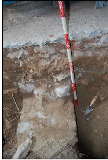
Detall del mur de pedres i totxanes lligades amb morter (UE: 206)
