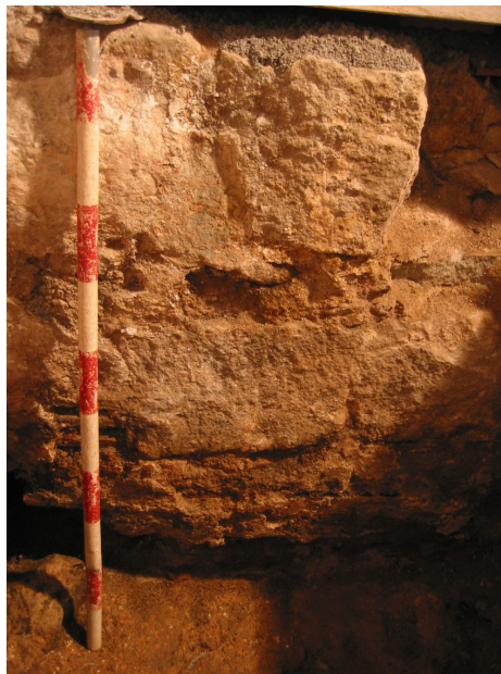
Vista del mur U.E. 505.
