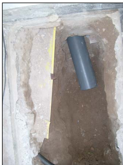
Fotografia 22. Tub de connexió amb el clavegueram.
