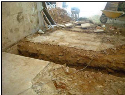
Fotografia 18. Detall de la rasa (UE:300) un cop finalitzada la seva excavació.
