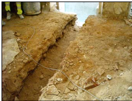
Fotografia 17. Detall de la rasa (UE:300) un cop finalitzada la seva excavació.
