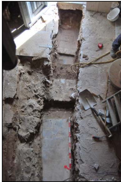
Fotografia 5. Vista general de la rasa (U.E.: 200) ja finalitzada.
