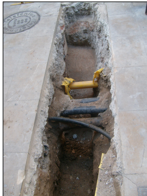
Rasa finalitzada on s'hi aprecien els tubs dels serveis
