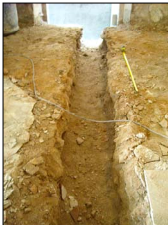
Fotografia 19. Detall de la rasa (UE:300) un cop finalitzada la seva excavació.
