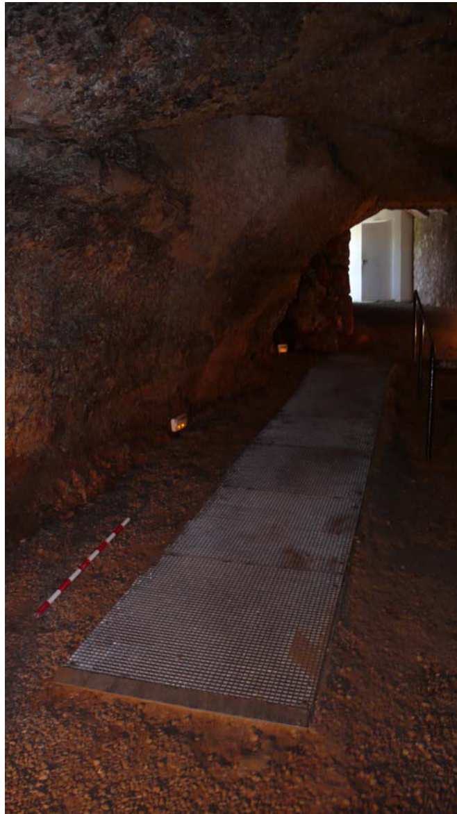
Figura 23.- Passarel·la existent a la cova de la Vila on s'efectuà el rebaixament per obtenir l'alçada necessària en el punt de connexió.
