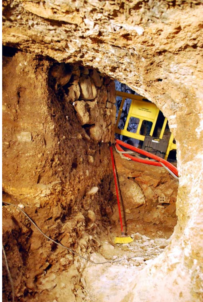
Figura 48.- Vista de la comunicació entre coves des de la cova de la Font Major, en procés d'eliminació de la part inferior de la paret de roca
