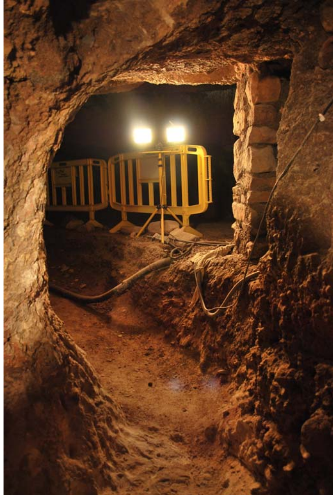
Figura 49.- Vista de la comunicació entre coves des de la cova de la Vila, una vegada finalitzats els treballs.
