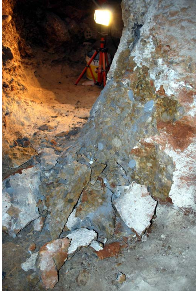
Figura 47.- Fracturació de la roca una vegada el ciment expansiu ha fet el seu efecte.
