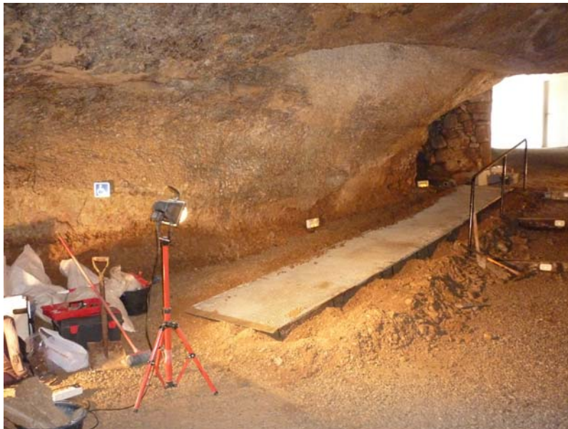
Figura 29.- Inici del procés de retirada de la rampa amb la finalitat de rebaixar el nivell de circulació.
