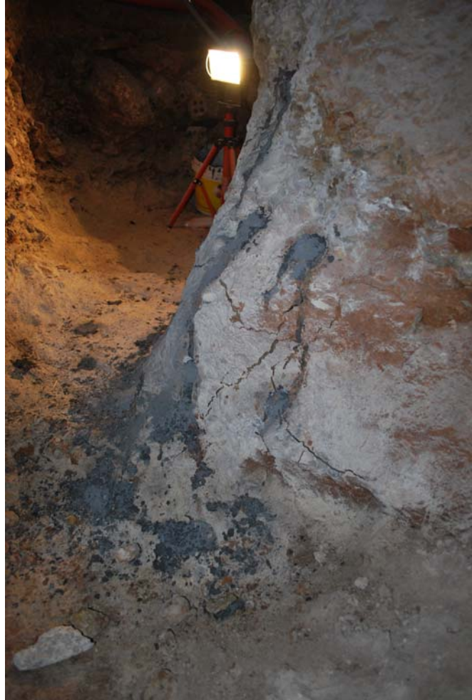
Figura 46.- Detall de l'aplicació del ciment expansiu que es va fer servir per fracturar el conglomerat.
