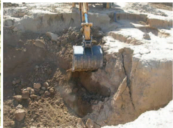
Excavació amb màquina d'E-8
