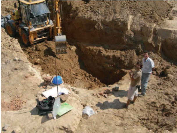
Fig. 11: Excavació amb màquina del retall inferior d'E-8 el 14 de setembre.
