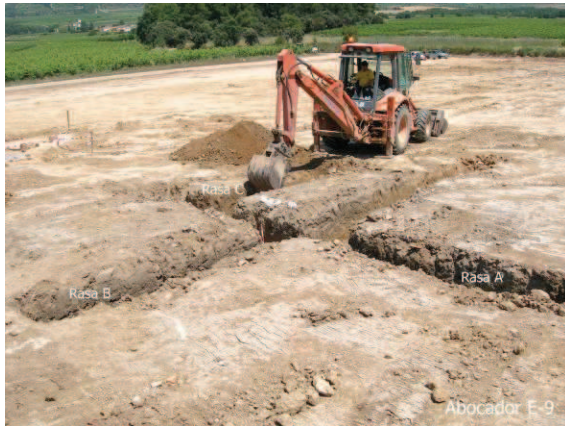
Abocador E-9: excavació de les rases.
