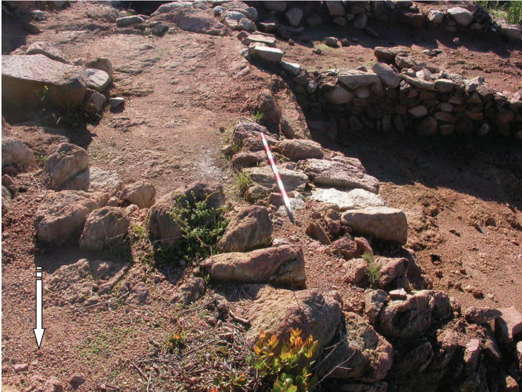
Làmina 11. Detall del mur 659 abans de consolidar.
