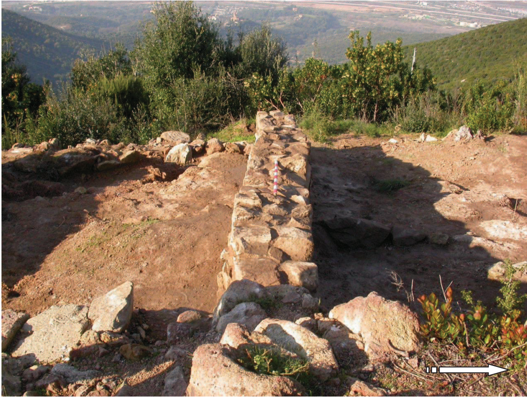
Làmina 15. Detall del mur 660 un cop consolidat.
