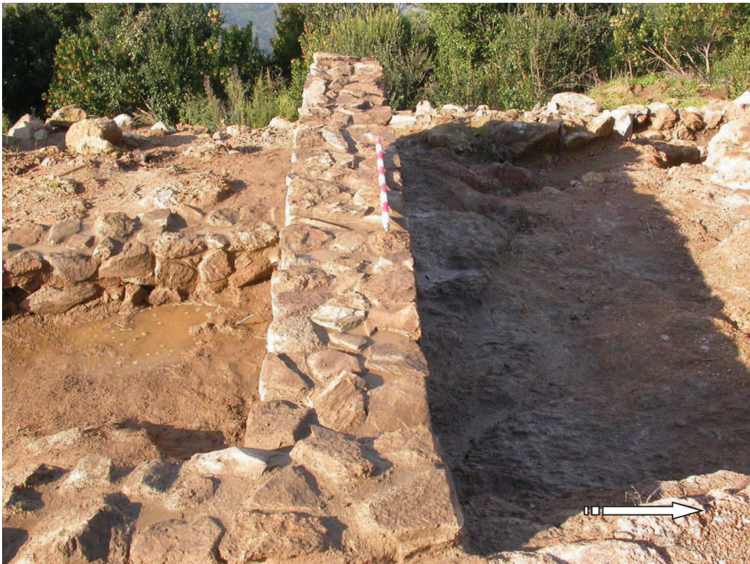
Làmina 16. Detall del mur 660 un cop consolidat.
