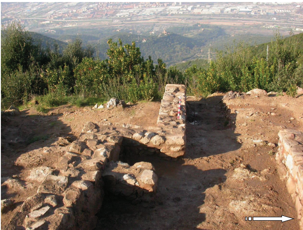
Làmina 13. Detall del mur 636 un cop consolidat.
