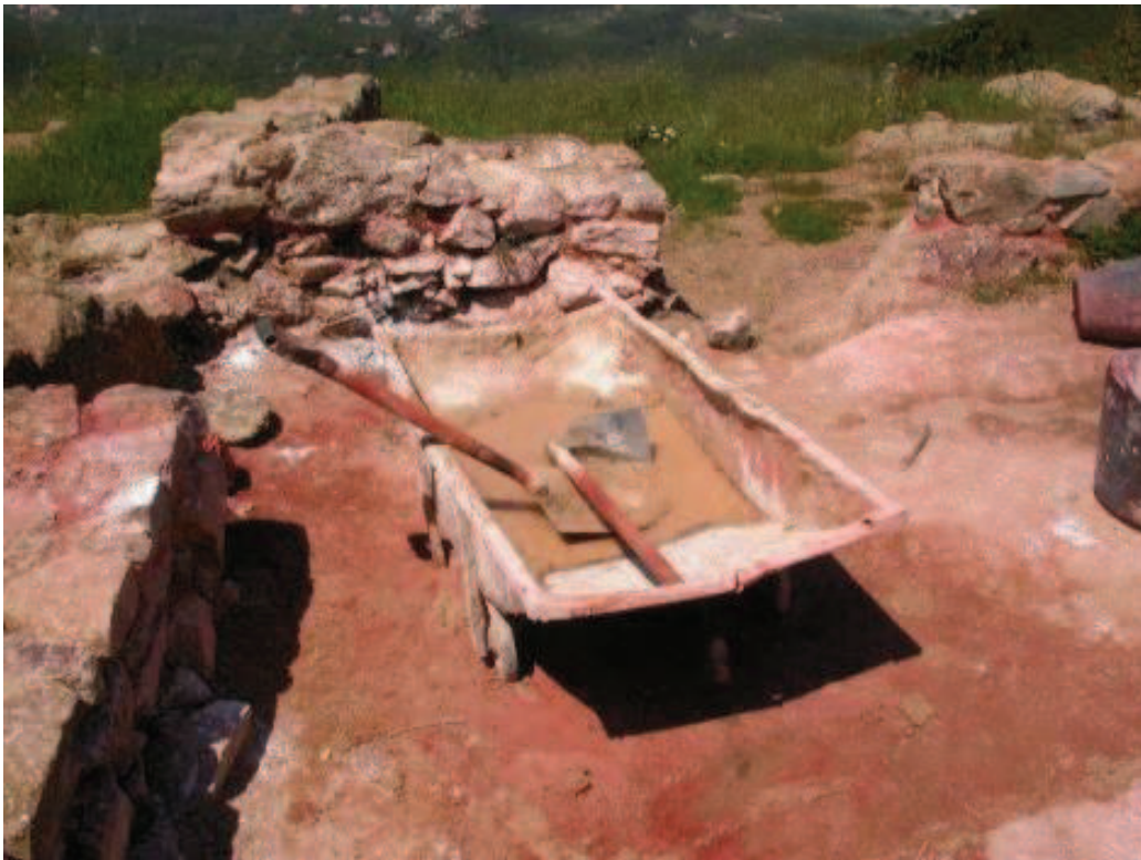
Làmina 2. Pastera per fer lel morter amb a barreja de terra, calç i arena.
