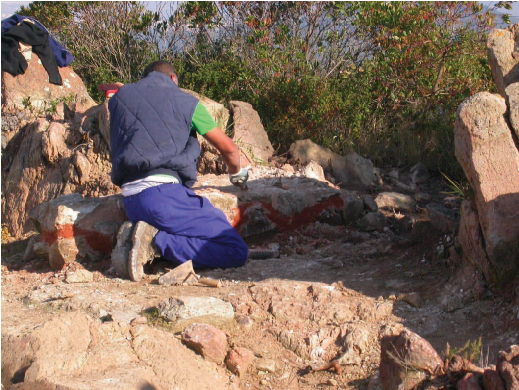
Làmina 18. Mur 662 en procés de consolidació.
