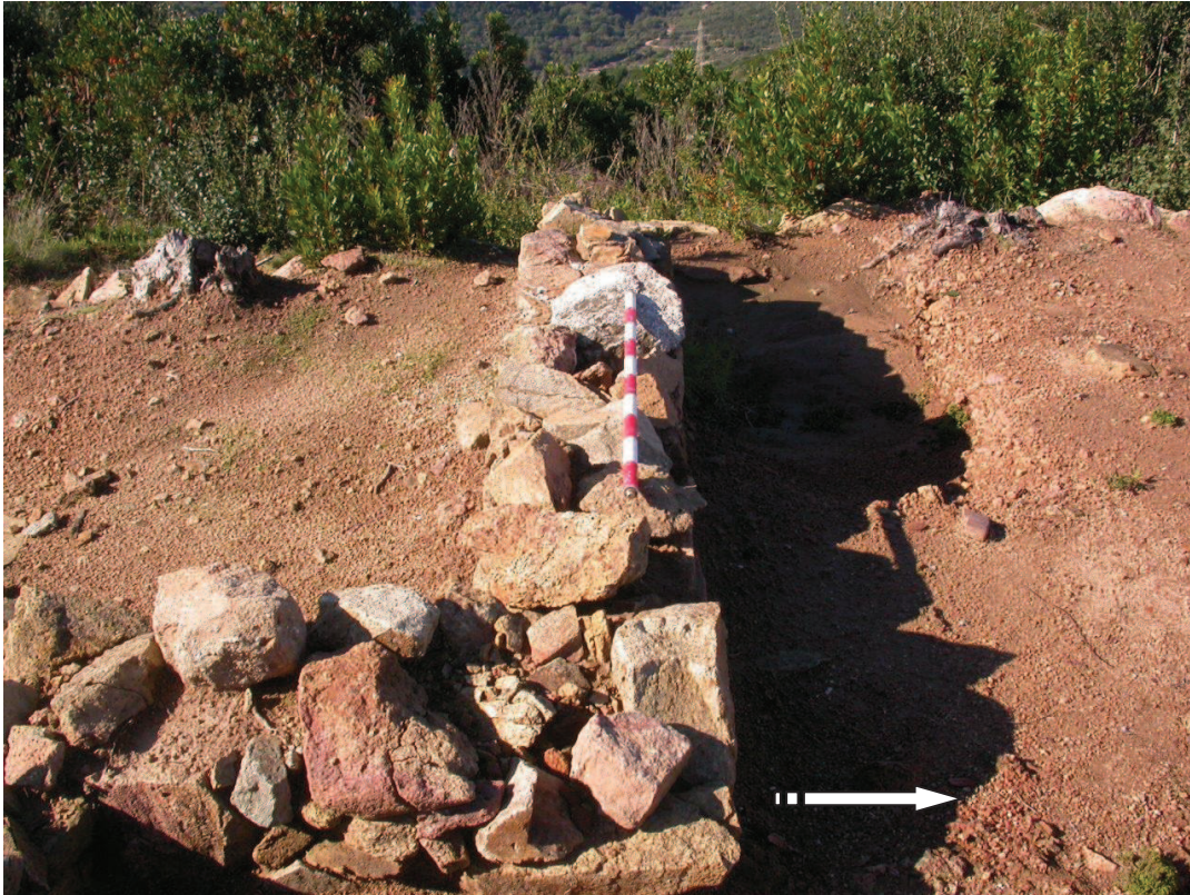
Làmina 3. Detall del mur UE: 636 abans de consolidar.
