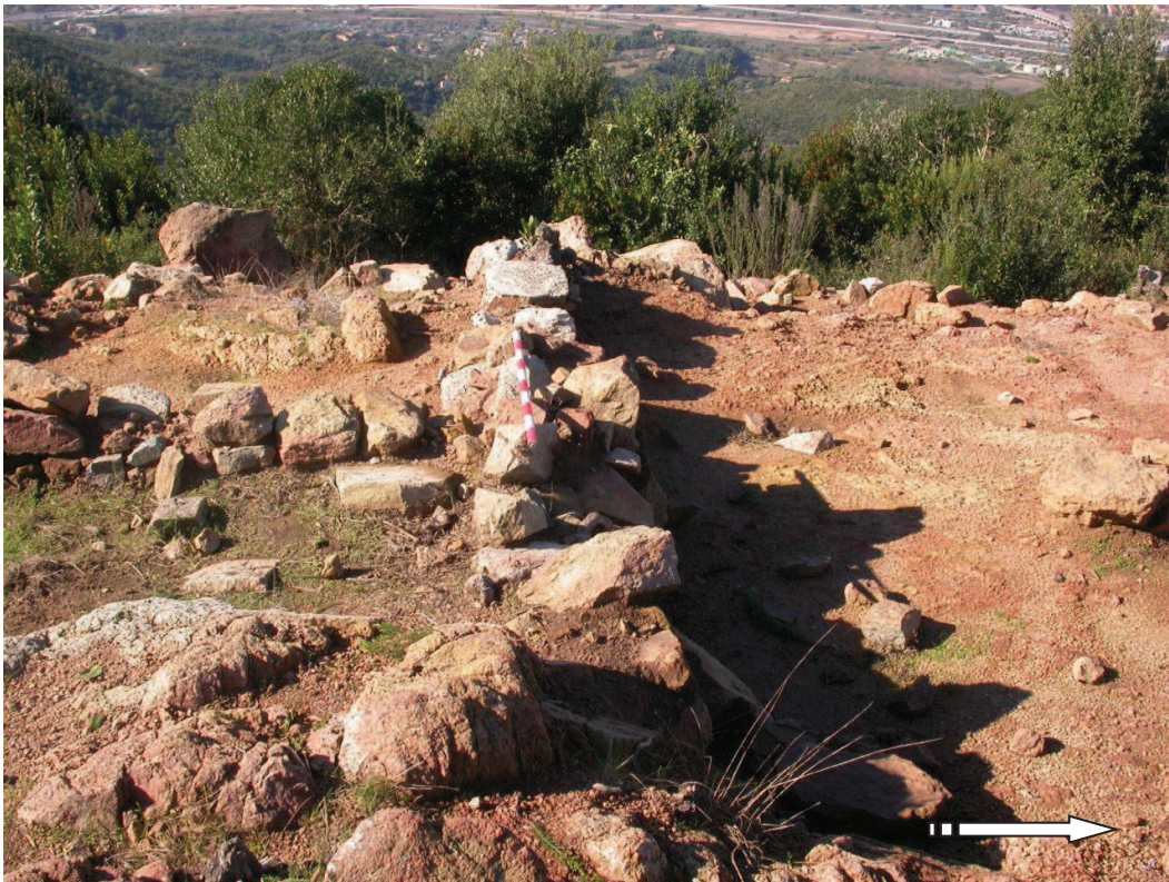
Làmina 10. Detall del mur 667 abans de consolidar
