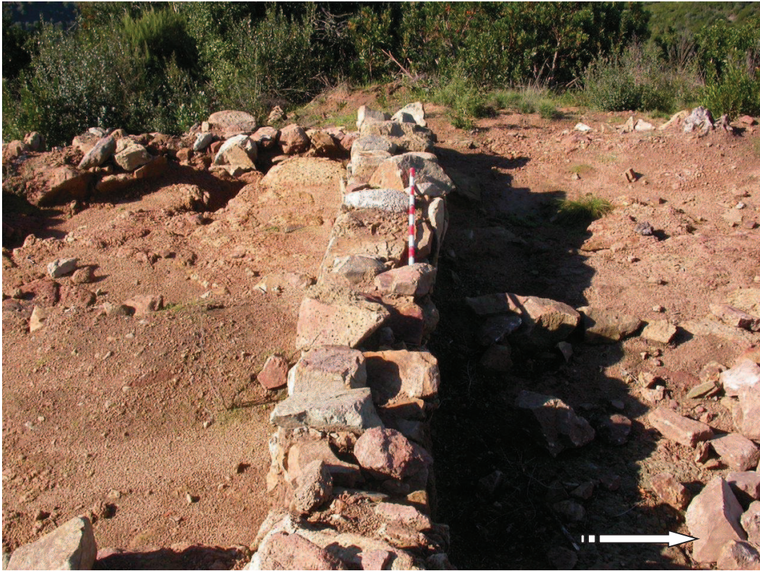
Làmina 7. Detall del mur 662 abans de consolidar
