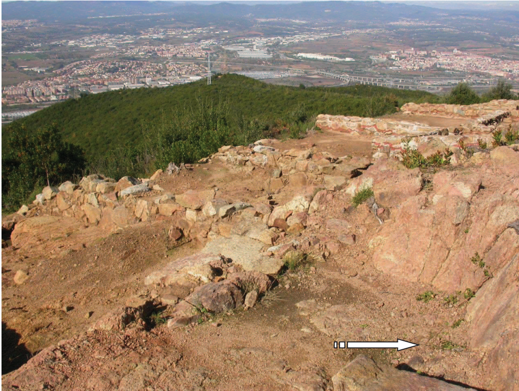
Làmina 1. Vista del sector a consolidar.
