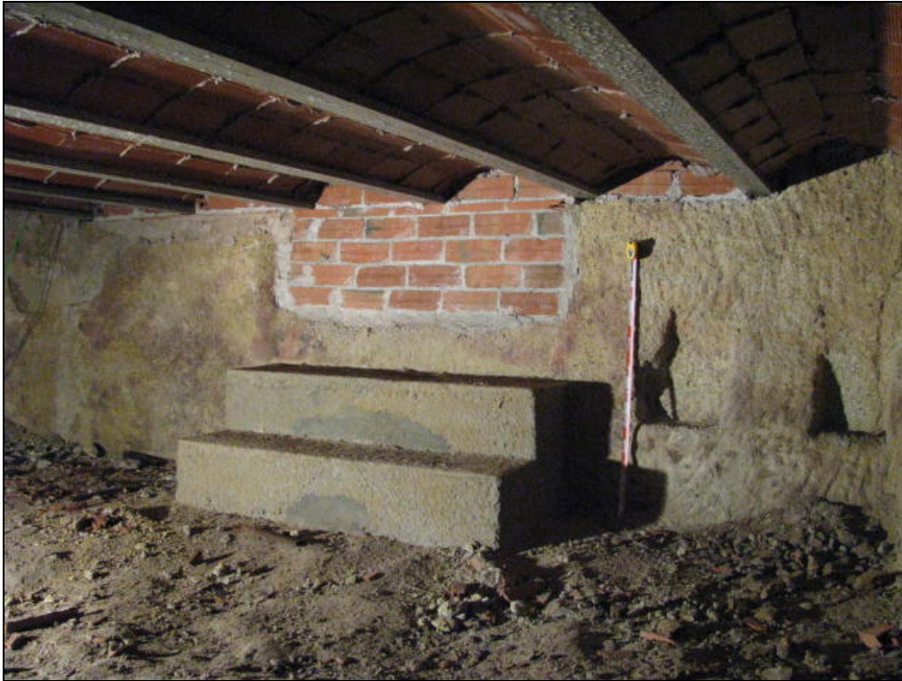
Foto 12: Habitació soterrada. Tancament oest.
