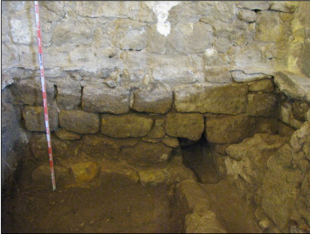
Foto 8: Detall dels murs UE 1005 i 1007 i canalització UE 1005.
