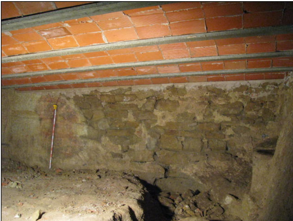
Foto 13: Habitació soterrada. Tancament nord.
