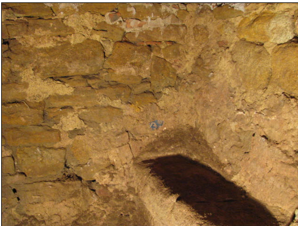
Foto 21: Ubicació de la rajola al mur UE 1005.
