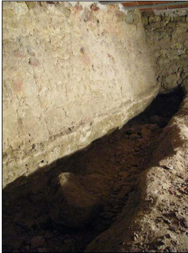
Foto 16: Habitació soterrada. Escarpa UE 3001 i rasa UE 3002.
