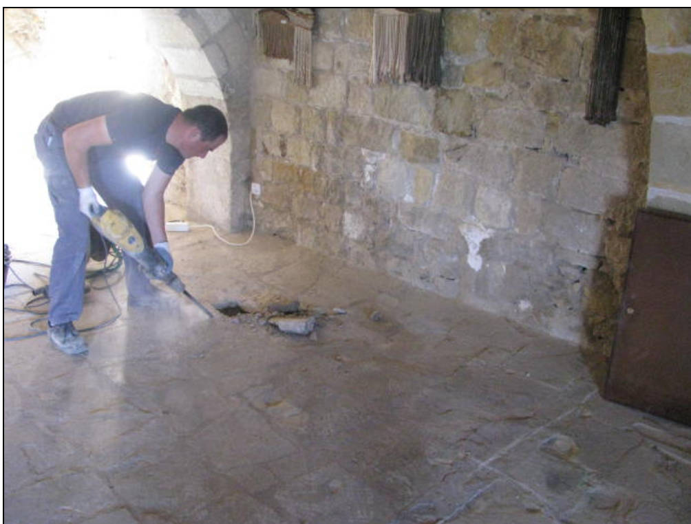
Foto 3: Obertura del sondeig 1 amb martell pneumàtic.
