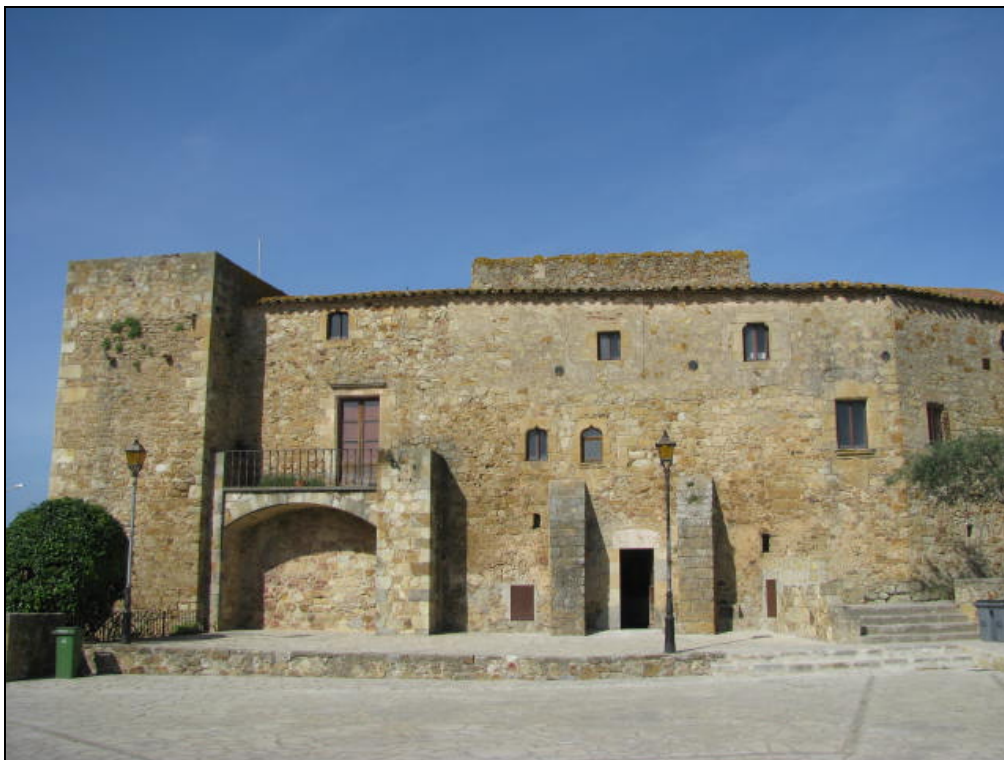
Foto 2: Vista del lateral est de Ca la Pruna.
