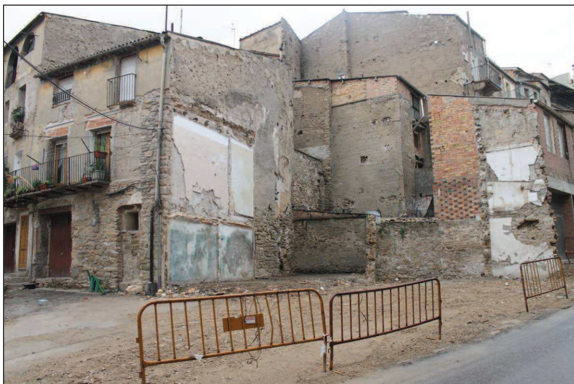
Fotos 36 i 37. Final de l'Enderroc.
