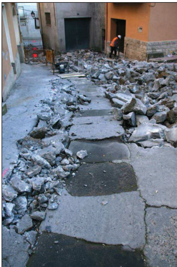
Foto 3. Demolició del paviment del carrer Sant Joan.
