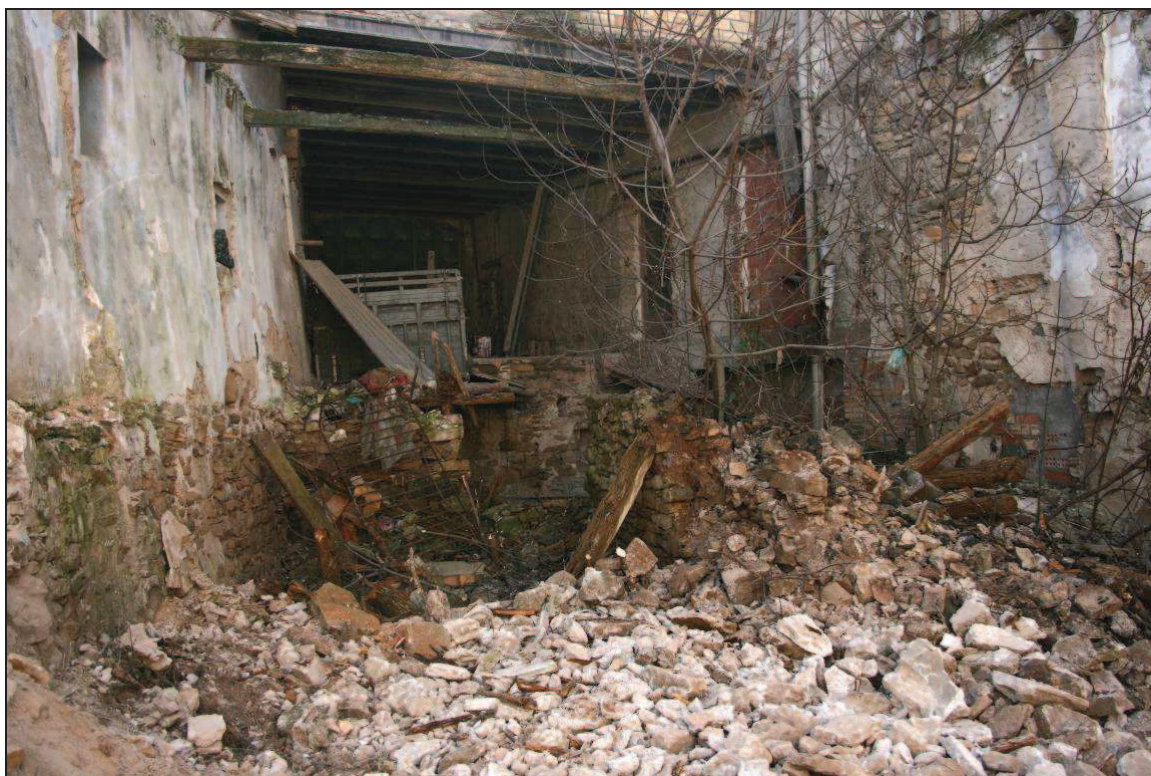
Fotos 21 i 22. Procés d'enderroc de l'immoble.
