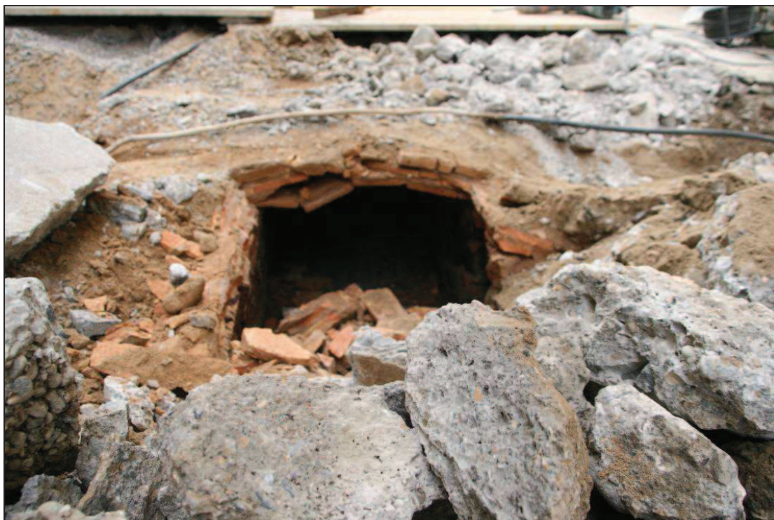
Foto 8. Volta de maó de la claveguera.
