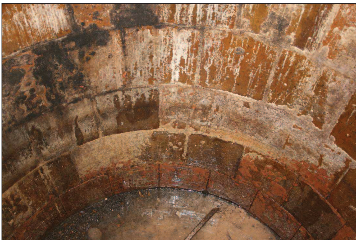
Foto 15. Detall de les parets de maons del trull.
