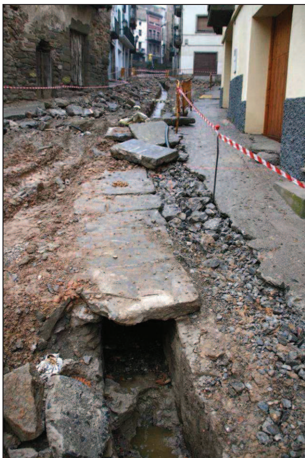
Foto 5. Desmuntatge de la claveguera.
