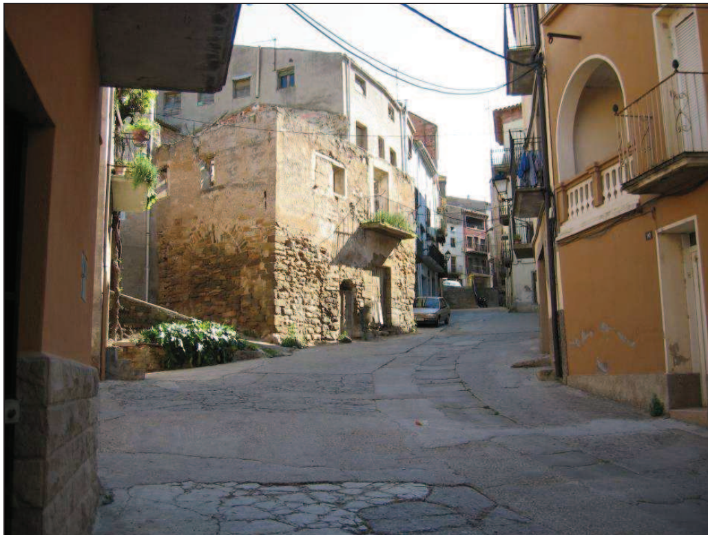
Foto 1. Carrer Sant Joan abans de l'inici de les obres.
