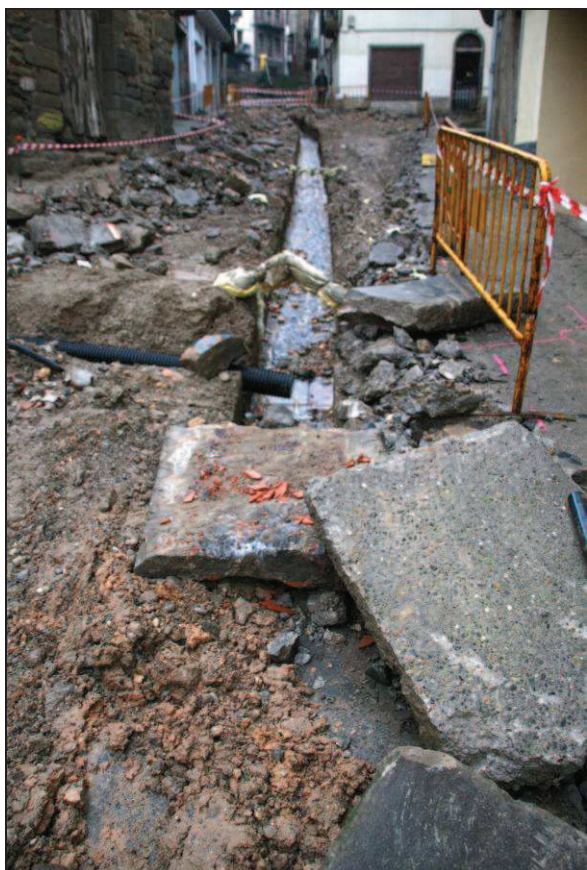
Fotos 6 i 7. Claveguera del carrer Sant Joan un cop extretes les lloses que la cobrien.
