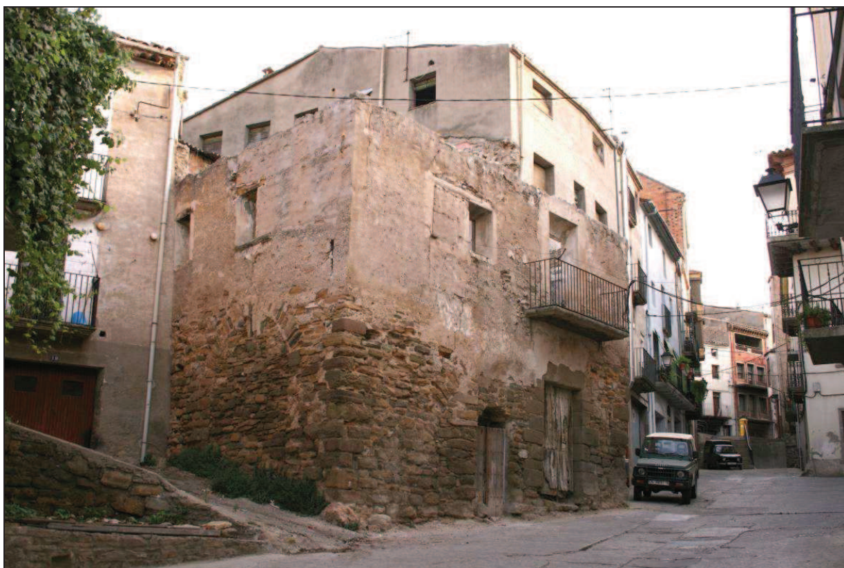
Foto 17. Immoble en ruïnes abans de ser enderrocat.
