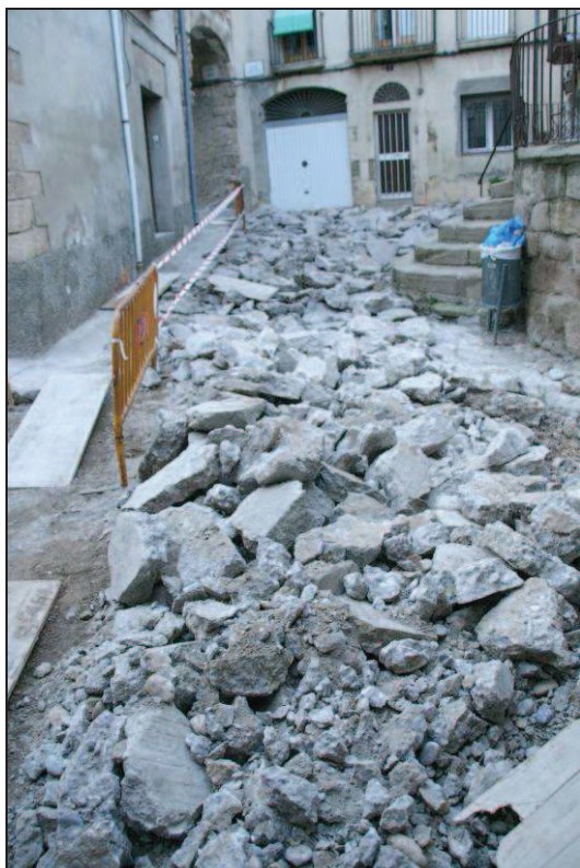
Fotos 25 i 26. Demolició del paviment de formigó.
