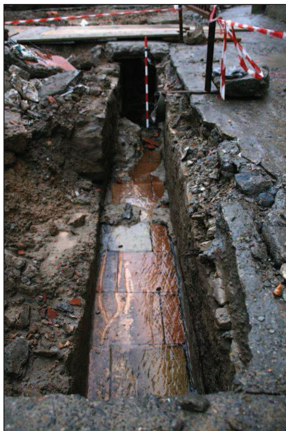
Fotos 6 i 7. Claveguera del carrer Sant Joan un cop extretes les lloses que la cobrien.
