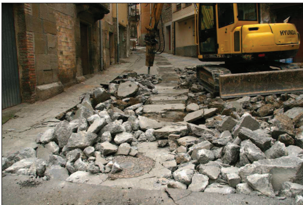
Foto 2. Demolició del paviment del carrer Sant Joan.
