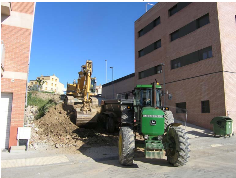
2. El procés de rebaix mecànic de la capa més superficial.
