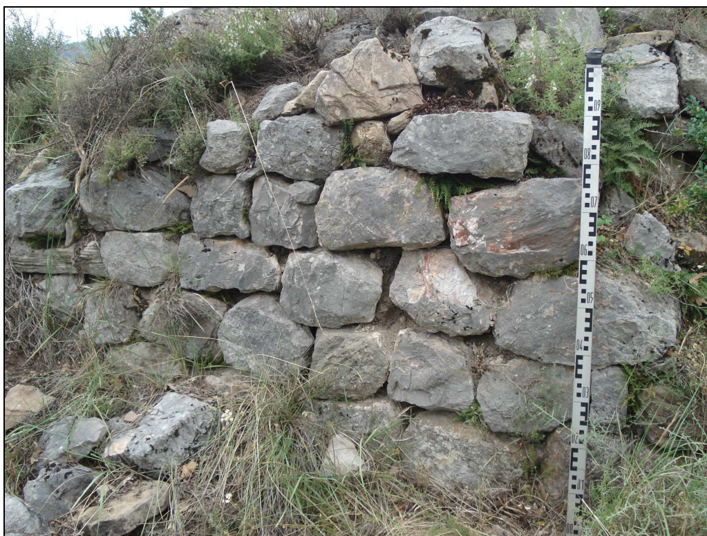
Figura 14. Parament de carreus del mur meridional.
