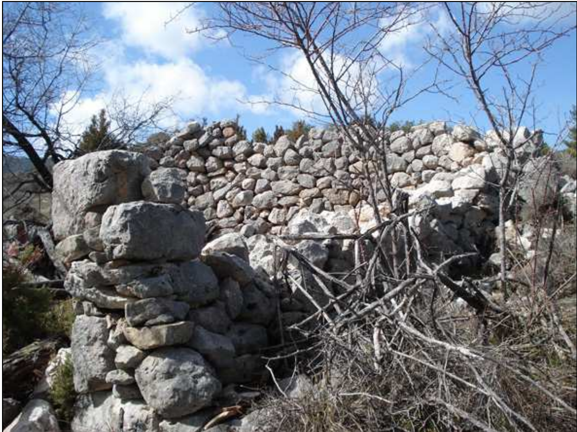
Figura 3. Barraca pròxima a l'antiga església de Sant Quiro, construïda amb carreus procedents de l'antiga església.
