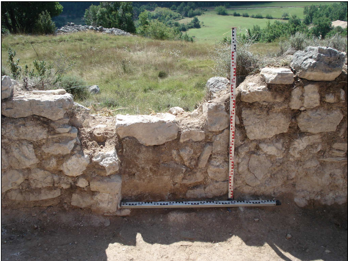
Figura 17. Aspecte de la porta tapiada al mur meridional.
