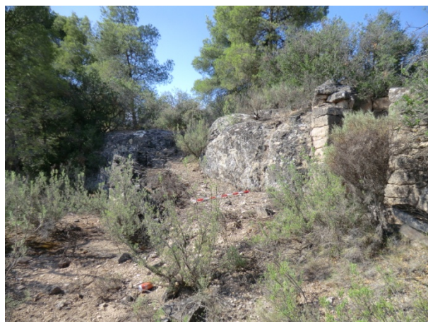
6. Entrada de la cabana i rampa d'accés a aquesta (on hi ha el jaló), en part excavada a la roca i en part construïda amb una paret de pedra seca (PI-1).
