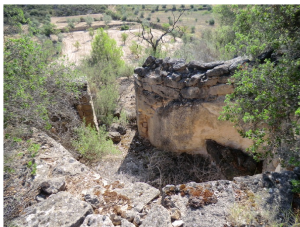
4. Vista de la cabana, com es pot veure en bona part excavada a la roca (PI-1).
