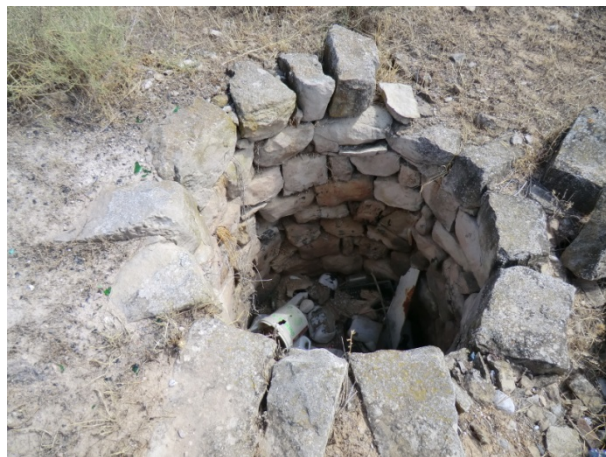
2. Pou de pedra seca ubicat a l'interior del tancat de tàpia (PI-3).
