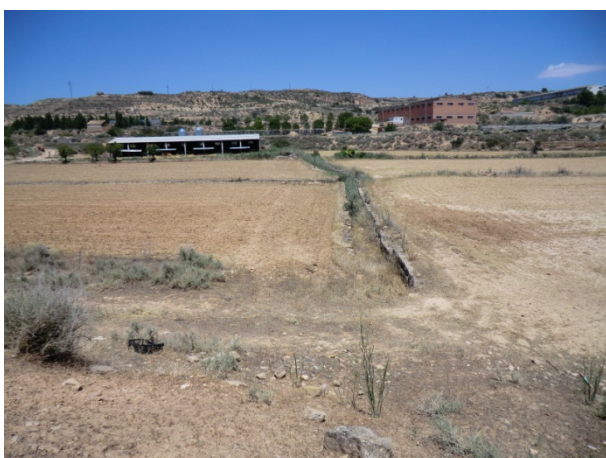
3. Canal de parets de pedra seca (PI-7) en sentit nord-sud, que enllaça (al centre de la imatge), amb el canal en sentit est-oest que genera els PI-5, PI-6 i PI-8.
