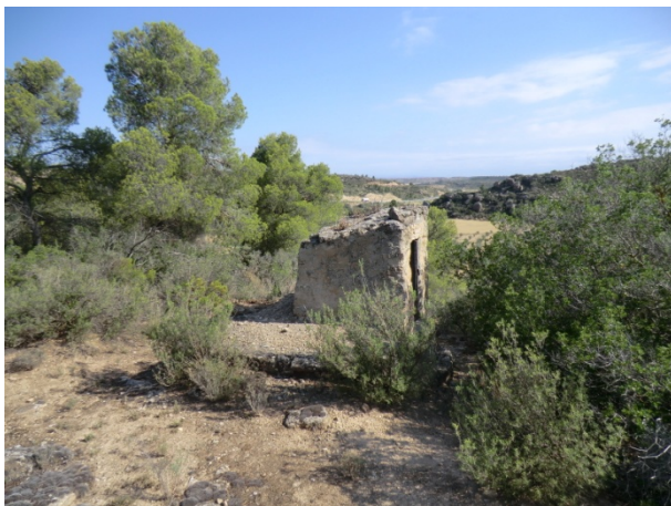
1. Vista de l'estructura de coberta de l'aljub (PI-1).
