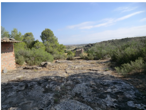
3. Vista dels canals de recollida d'aigua que la canalitzen vers l'aljub, al fons de la imatge (PI-1).
