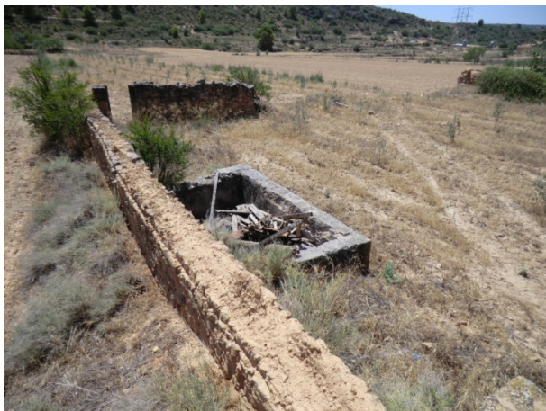
1. Safareig situat dins un tancat amb fonamentació de pedra seca i a sobre paret de tàpia, pràcticament desapareguda (PI-10).
