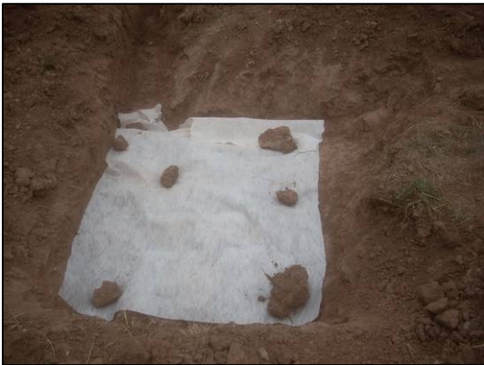
Geotèxtil col·locat al sondeig realitzat a la Zona 5
