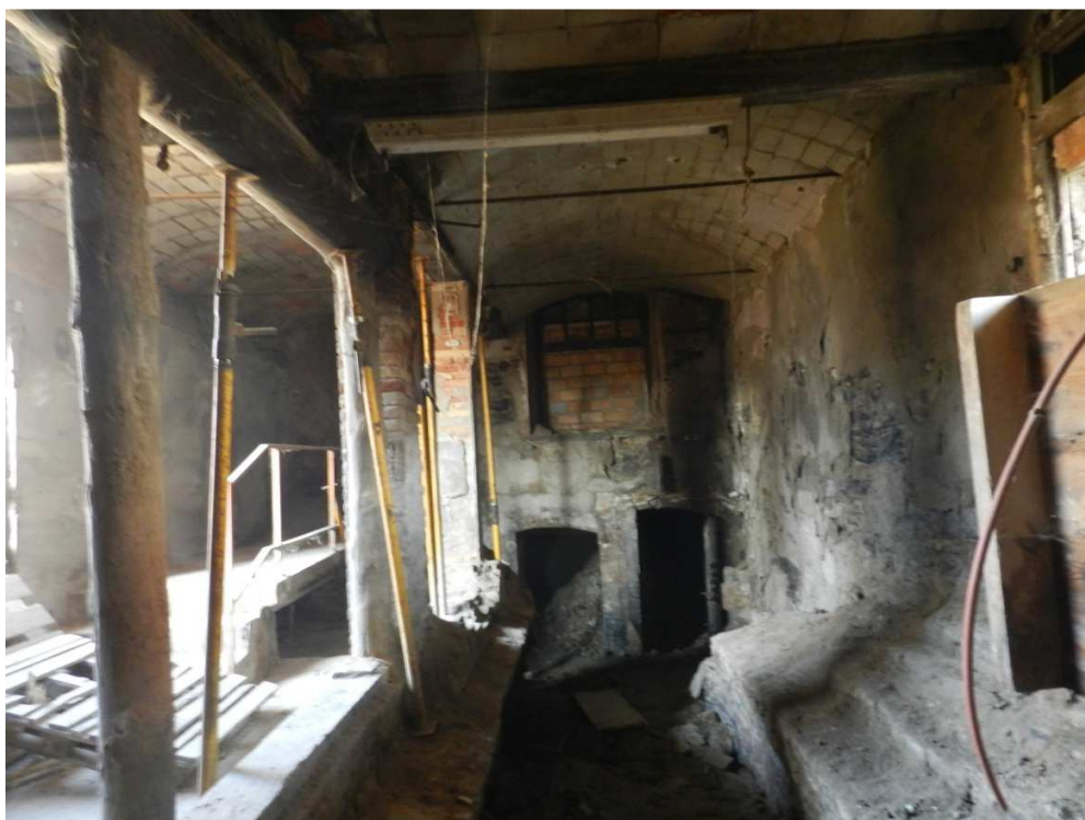
Sala de calderes, abans de la caiguda de la volta
