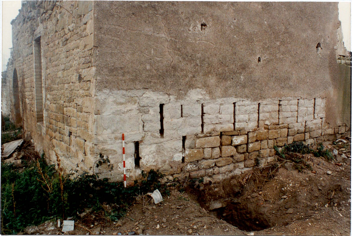
Detall del parament exterior de la muralla (est).
