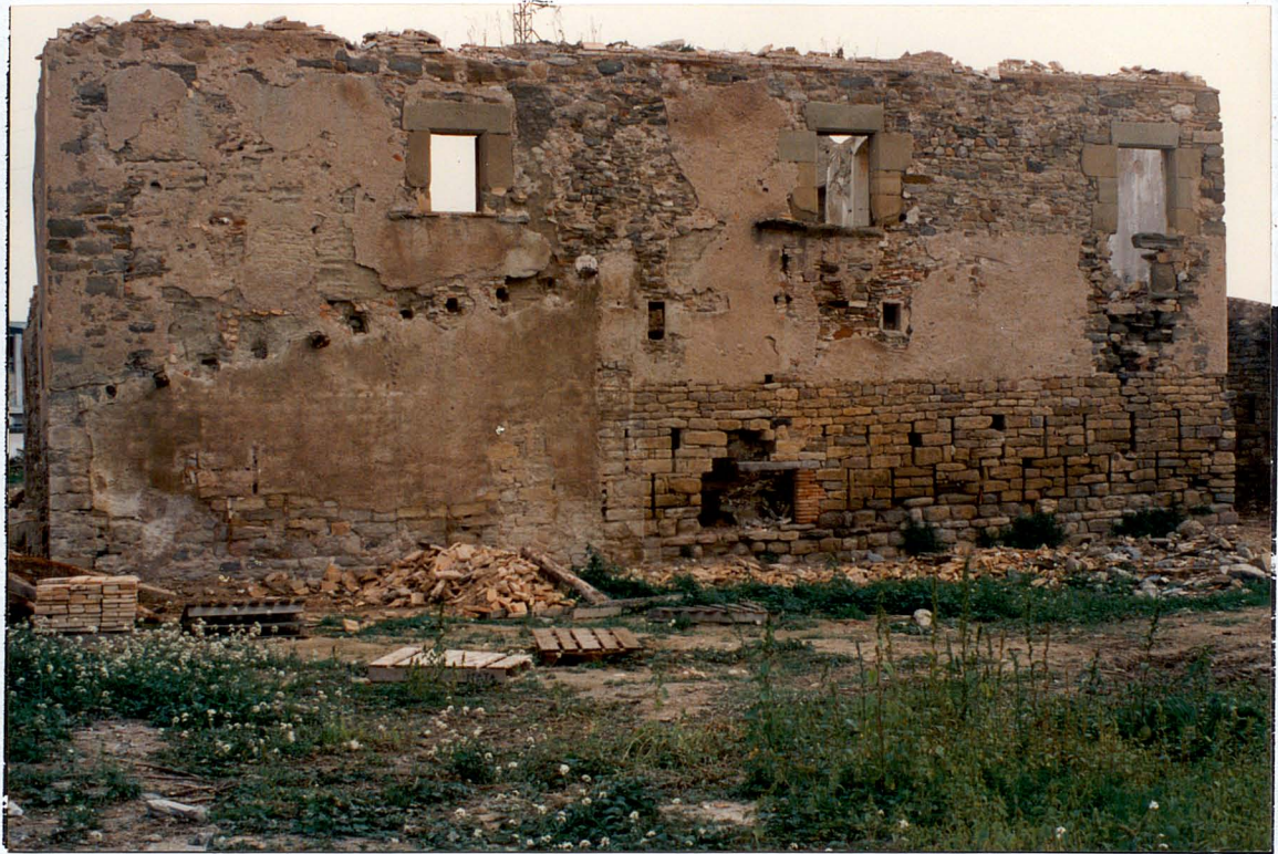
Parament exterior de la muralla (oest). Observi's, a la planta baixa, la doble filada d'espitlleres.
