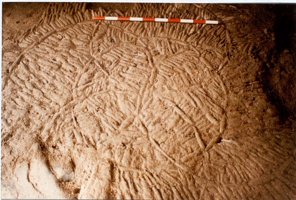
Detall del paviment de palets de riu, formant cercles secants, a l'interior de la torre.
