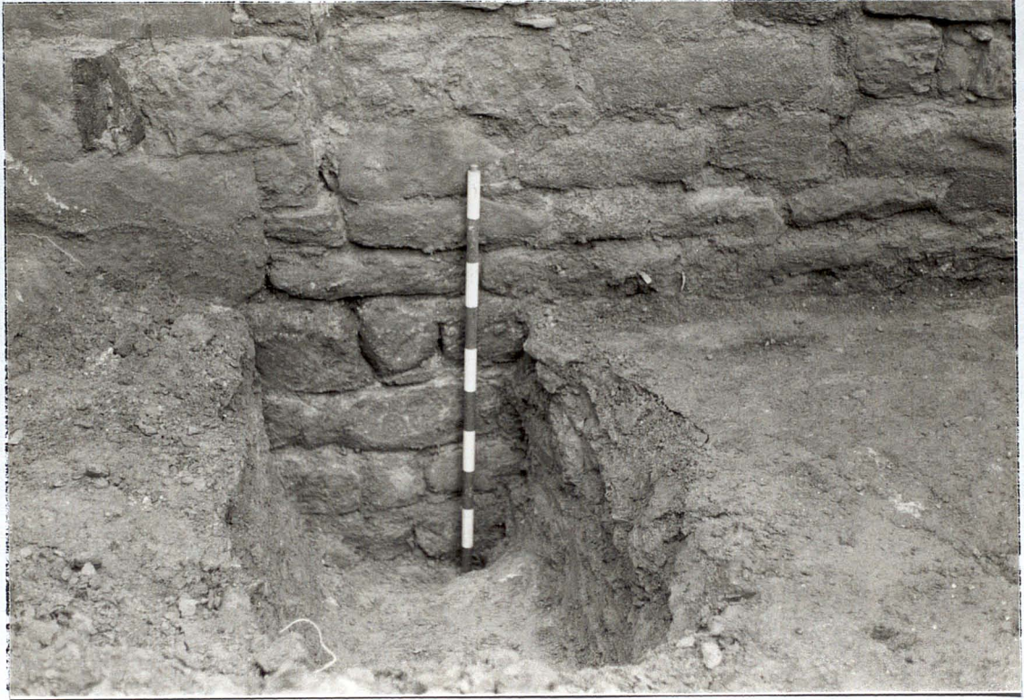
Sondeig C. El mur romànic continua per sota del nivell del tapàs.
