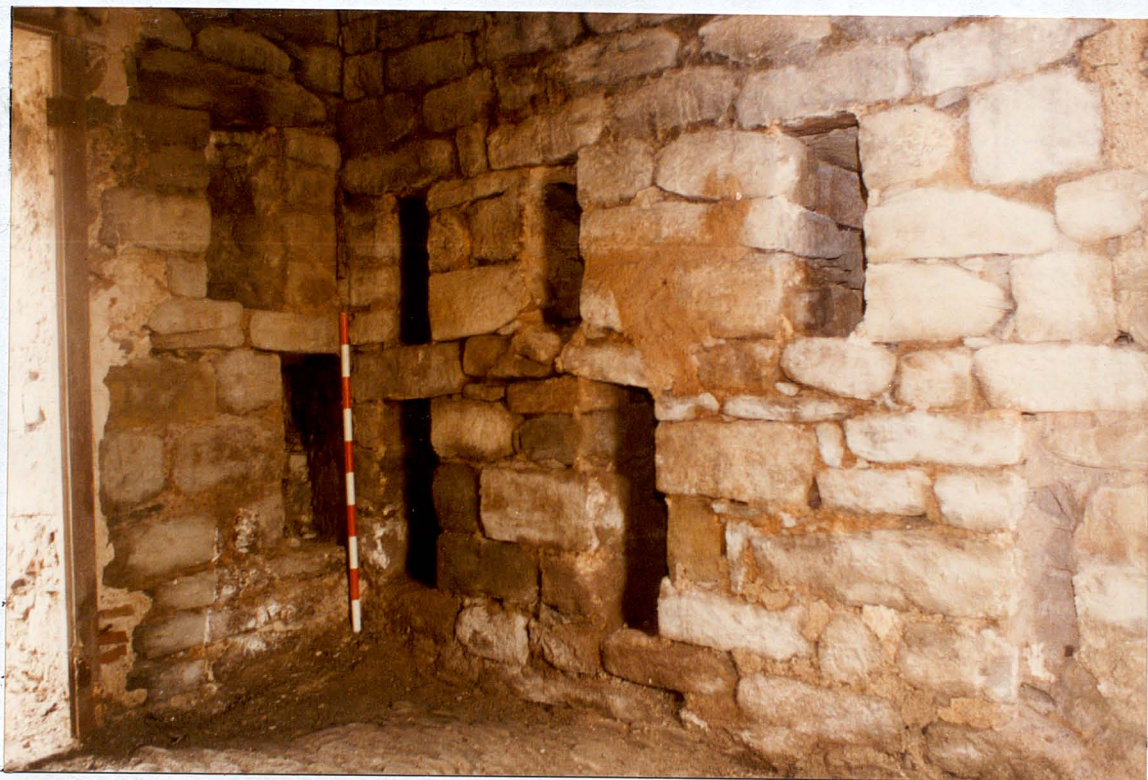
Interior de la torre, amb la doble filada d'espitlleres.
