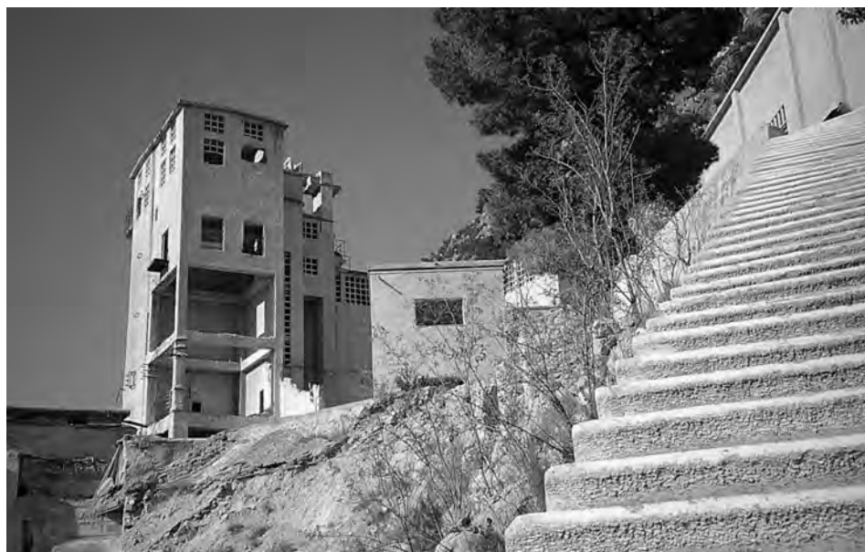
Fàbrica de ciment de dalt. Fotografia de Violeta Quiroga.
