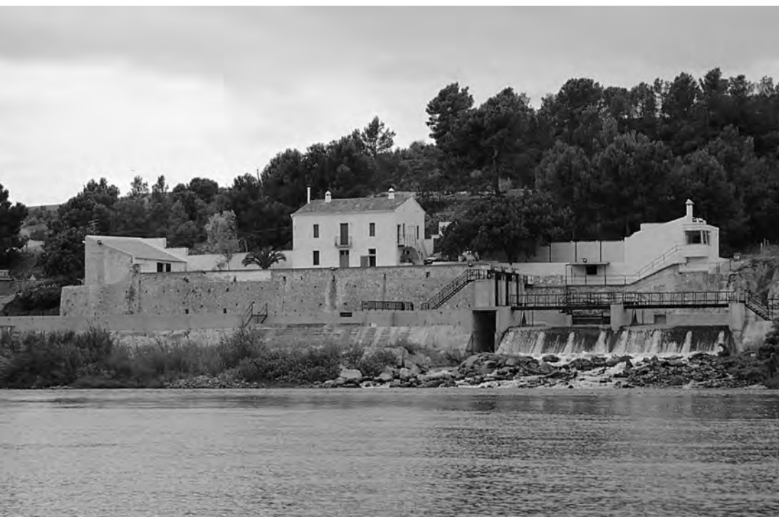
Resclosa de Xerta, totalment restaurada i habilitada per a la nova navegació. Fotografia de David Montserrat.
