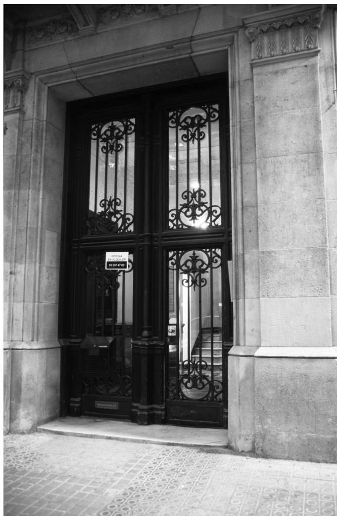
Entrada de la finca de la porteria 23.
