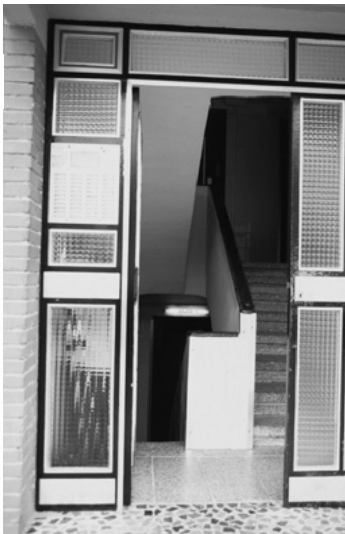
Entrada de la finca i al fons, semisoterrada, entrada de la porteria 4.
