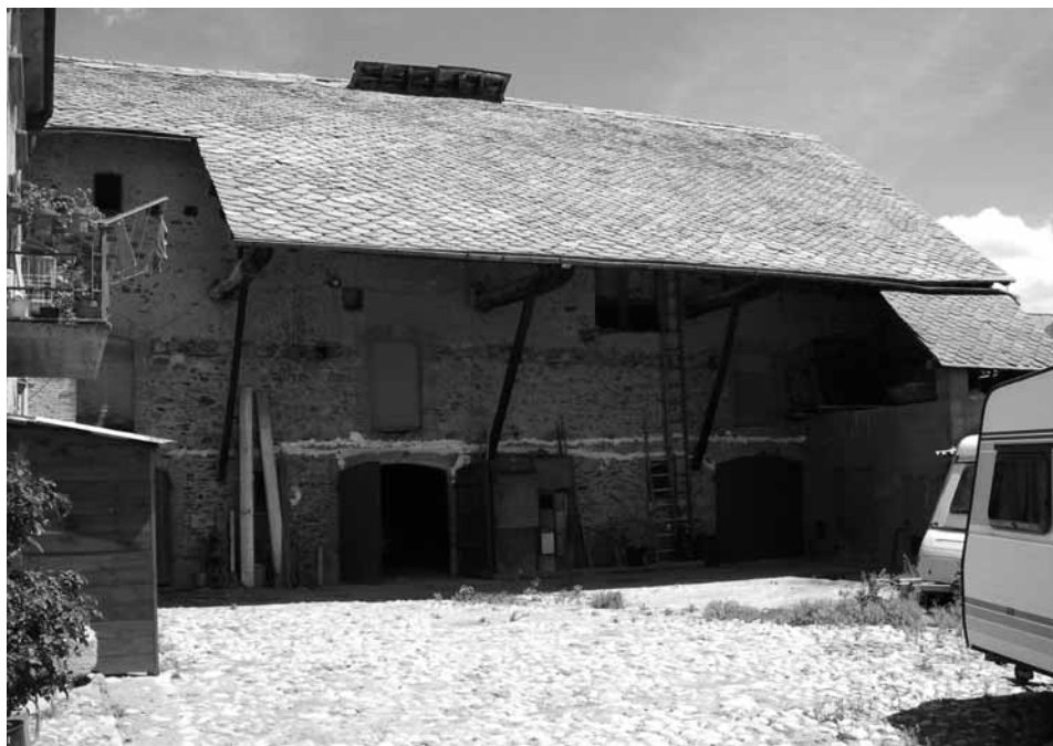
Estables i corrals de Cal Moxó amb l'era en primer pla. Fotografia dels autors del llibre.
