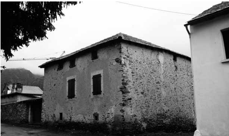
Parets exteriors de Cal Soler, a Er. S'observa l'arrebossat de calç combinat amb l'ús de la pedra per a emmarcar les obertures. Fotografia de Pere Campmajó. Arxiu IPEC.
