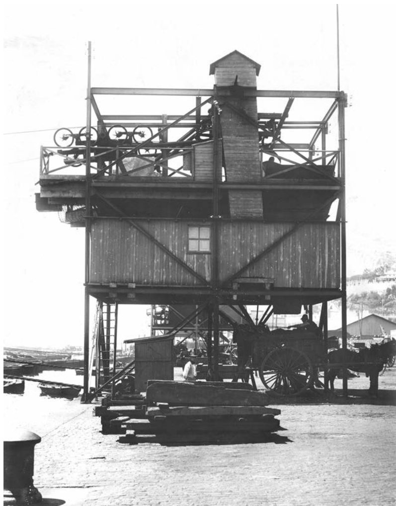
Foto 34. Unes «bicicletes». Aparell per a la descàrrega mecànica de carbó mineral, c. 1910. APB.
