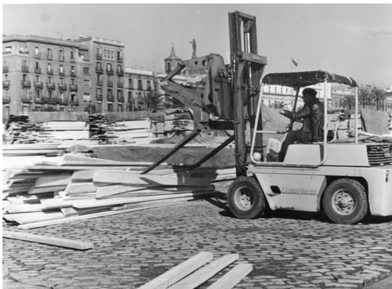
Foto 21. Manipulació de fustes amb toro al moll de la Fusta, 1966. APB.
