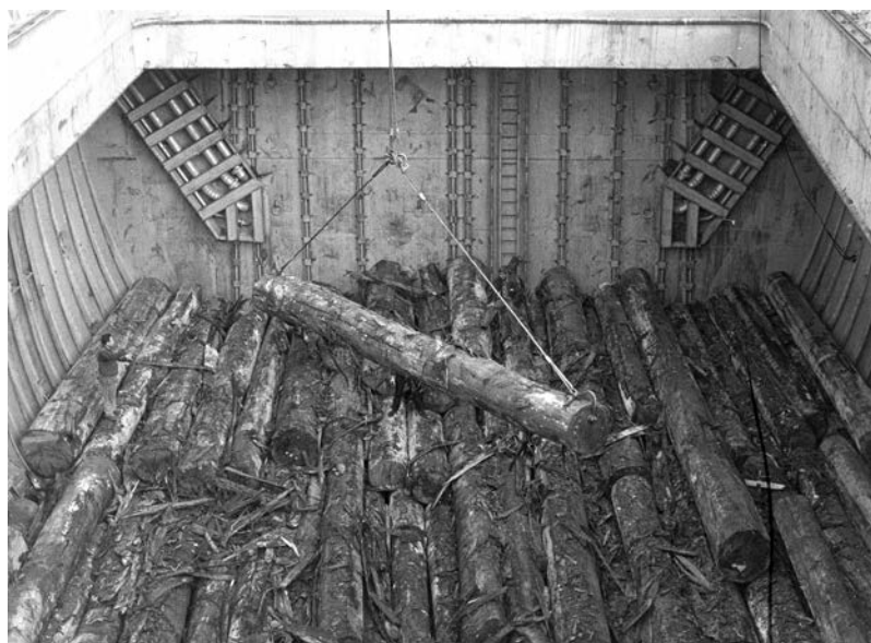
Foto 22. Una bodega amb troncs de Guinea a mig descarregar, 1966. APB
