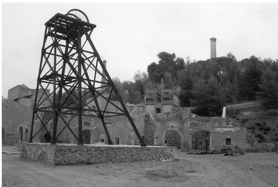
Torre del muntacàrregues de la mina alemanya. Fotografia de Francesc Fernández.
