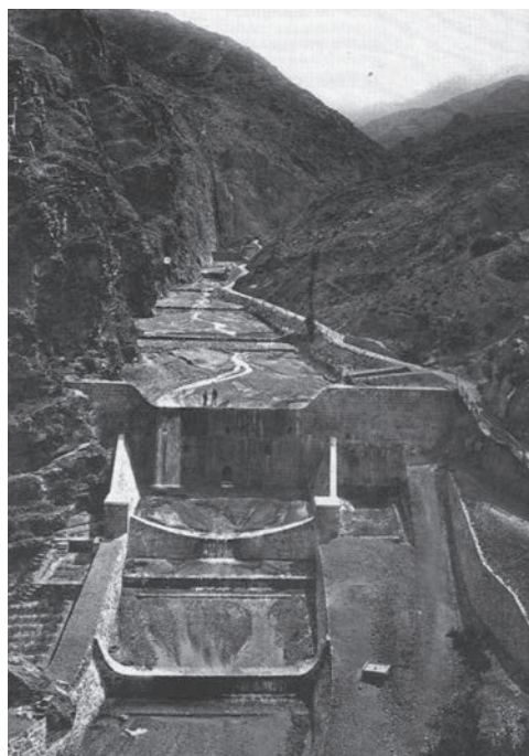
Obres de la correcció hidrològico-forestal del barranc d'Enseu. Autor desconegut. Any 1907.
