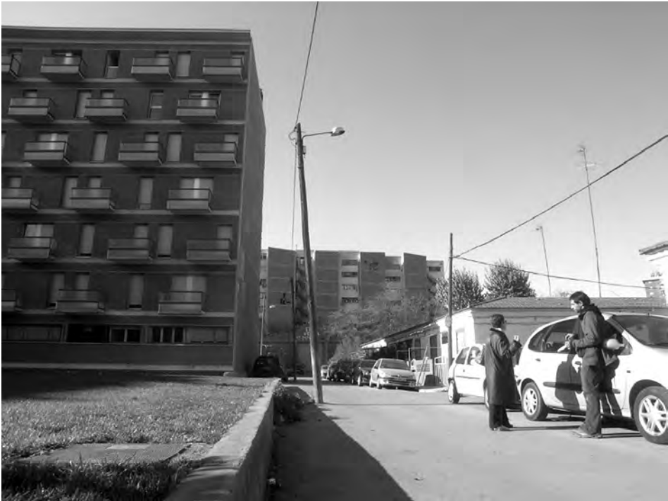
Els blocs de la primera fase acabats de construir, amb les cases del carrer Granadella al davant. Silvia Minarelli, 2004
