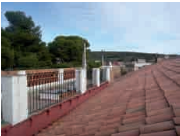
Estructura del rentador al terrat.
