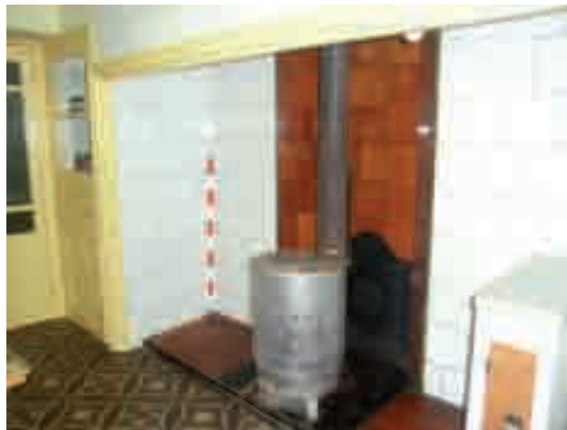
Zona de la llar a terra.
