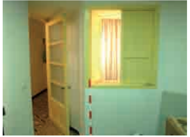
La finestra de l'altra habitació vista des de l'exterior, avui dia a l'interior de la casa.
