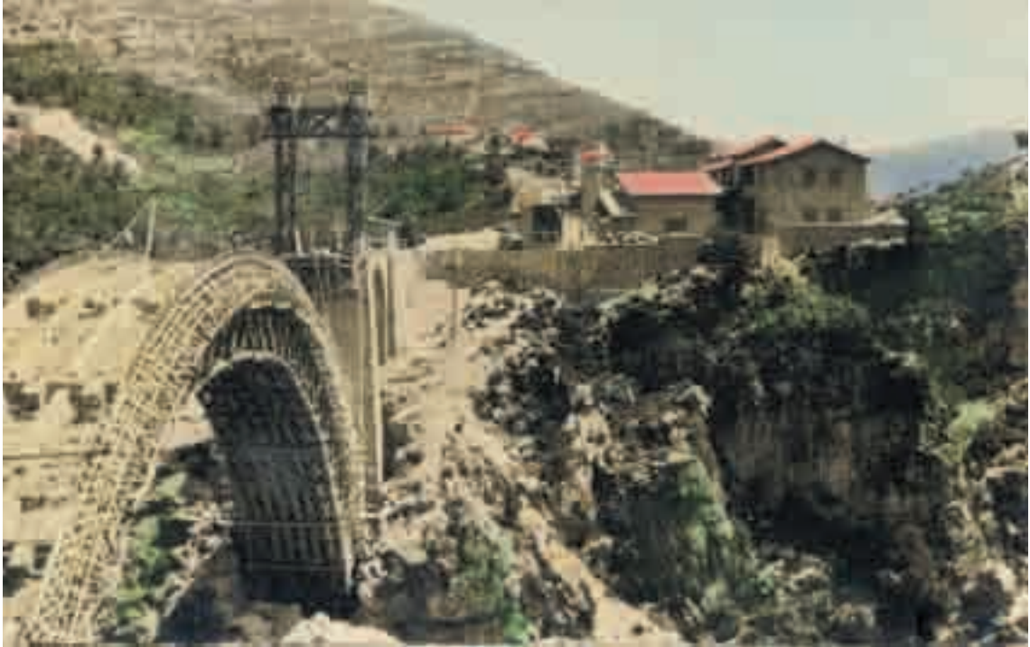
Obres de construcció al pantà. En primer terme cintra del pont i al fons caserna de la Guardia Civil, final anys 40.
