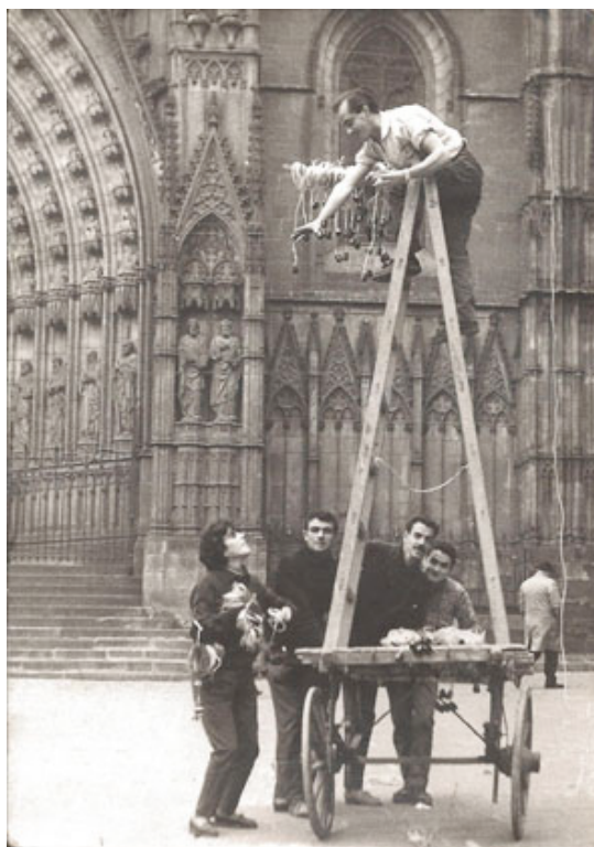
Instal·lació del cablejat elèctric de la Fira de Santa Llúcia. Arxiu Fontclara.
