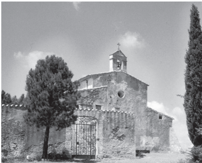
L'ermita de la Mare de Déu de la Consolació. Fotografia de Salvador Palomar
