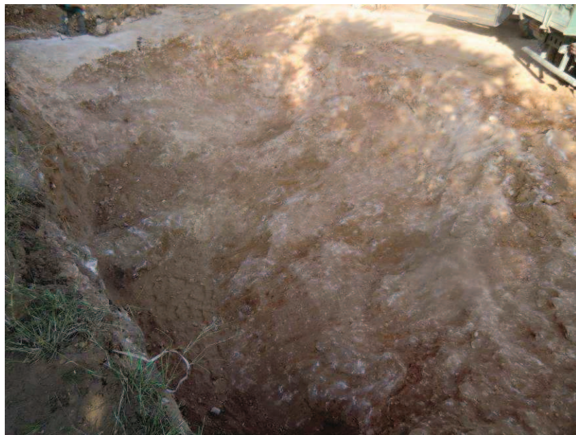
Fig. 8-9: Inici dels treballs de buidat del 2002 i foto final.
