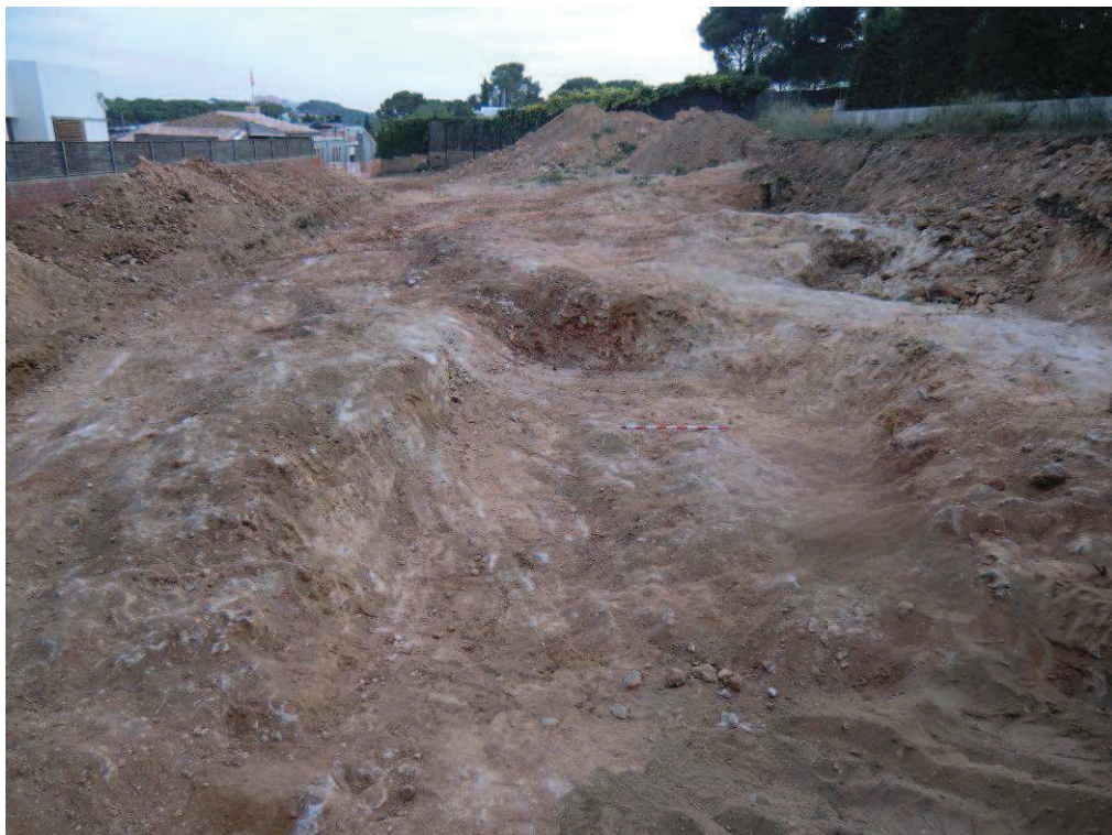
Fig. 23: Foto final de la parcel·la totalment excavada fins a roca mare.
