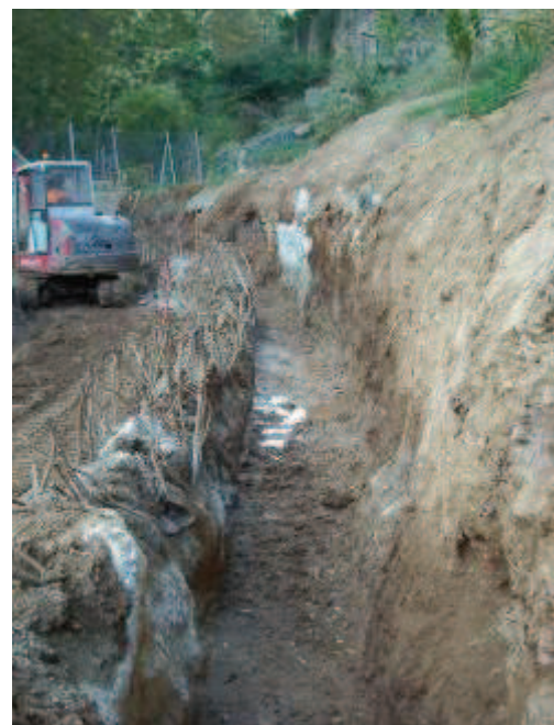
Fig.13: Fase 4. Sanejament rases laterals rampa sortida emergència i adreçament de barnilles.
