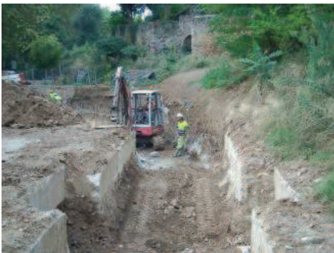
Fig.13: Fase 4. Sanejament rases laterals rampa sortida emergència i adreçament de barnilles.
