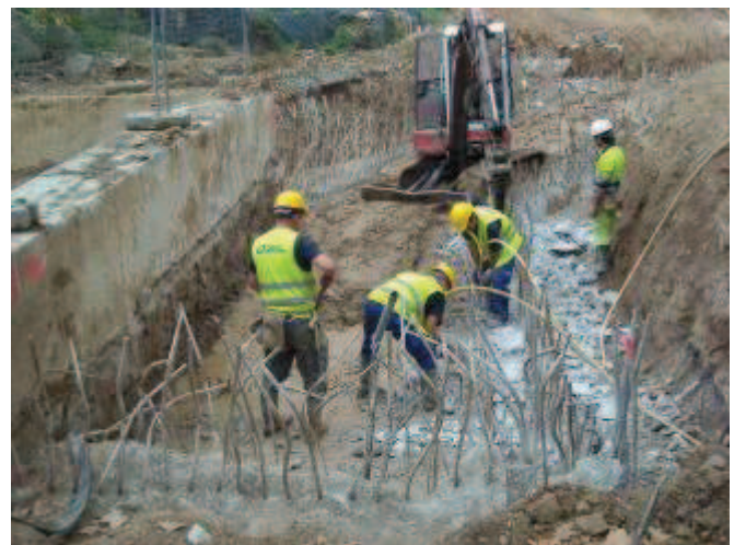
Fig.12: Fase 4. Sanejament rases laterals rampa sortida emergència i adreçament de barnilles.
