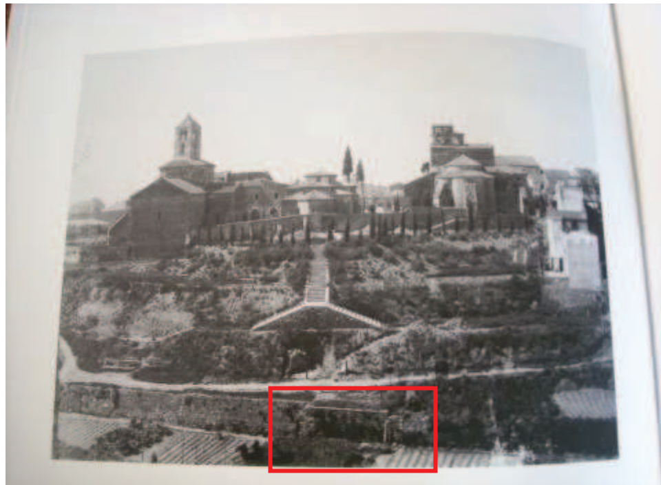
Fig. 11 . L'urbanització de l'entorn de les Esglésies de Sant Pere, era un aspecte primordial per Puig i Cadafalch (1929). Al peu de la foto s'observa l'EST1, el mur UE.114 (2010), i possiblement l'UE.204 (2013) i els horts al Torrent Monner del Parc de Vallparadis
