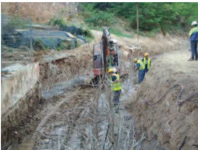
Fig.12: Fase 4. Sanejament rases laterals rampa sortida emergència i adreçament de barnilles.
