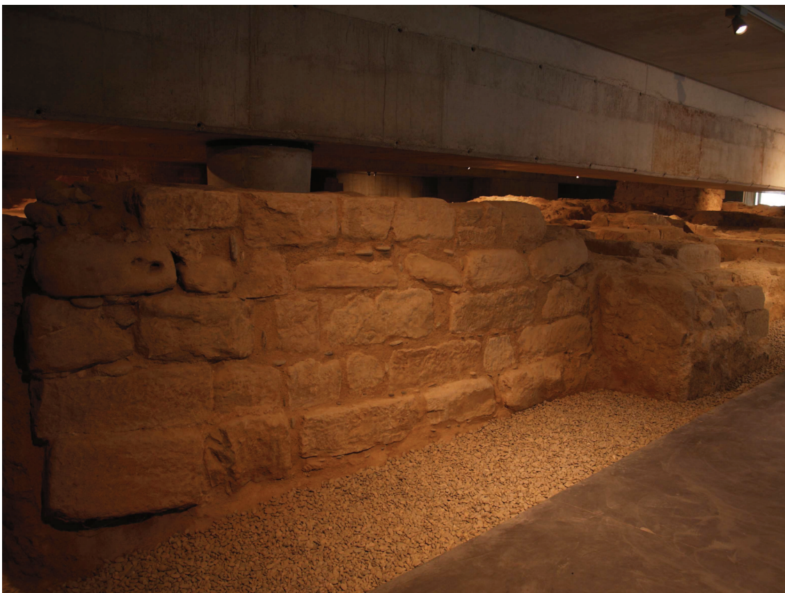
Imatge 6: mur del lateral sud del temple restaurat
