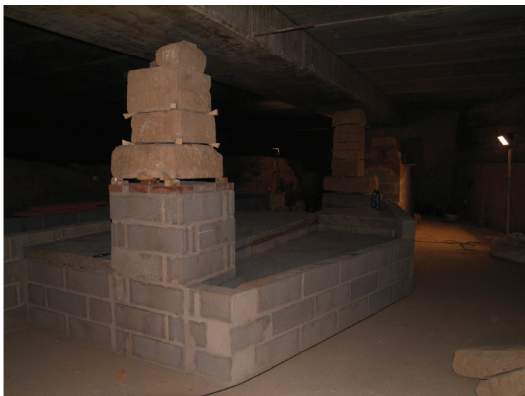
Imatge 7: plataformes construïdes per als pilars i tombes
