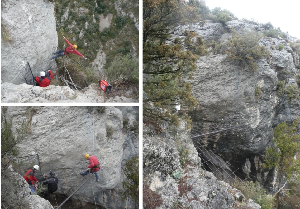
Figura 13. Imatge dels treballs de tancament de la cavitat i resultat final.
