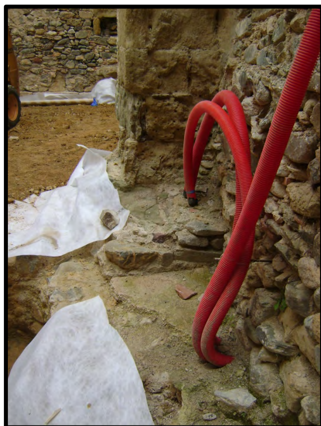
FOTO 3.- Col·locació geotèxtil en murs
