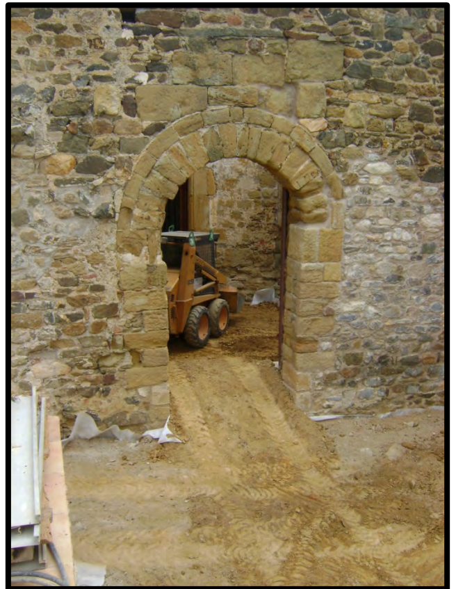
FOTO 6. Finalització treballs cobertura estructures
