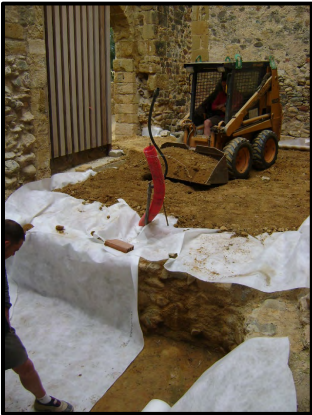
FOTO 5.- Treballs col·locació geotèxtil i colmatació
