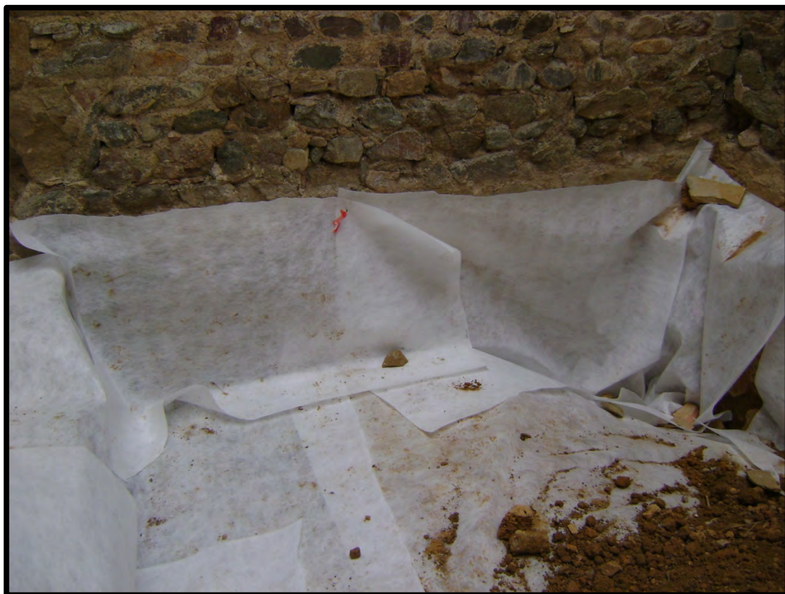
FOTO 1.- Vista general amb capa geotèxtil que cobreix les estructures arqueològiques
