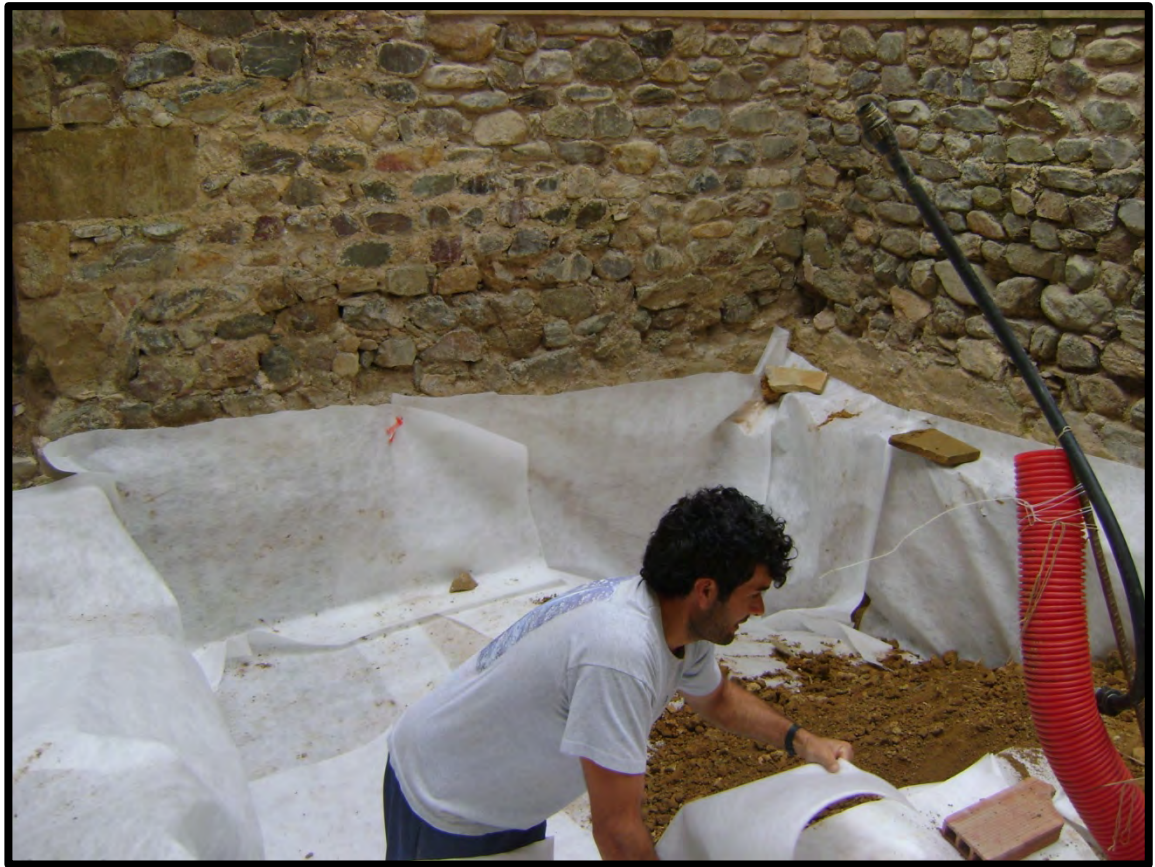
FOTO 4.- Col·locació geotèxtil protector de jaciment arqueològic abans de la seva cobertura amb terra
