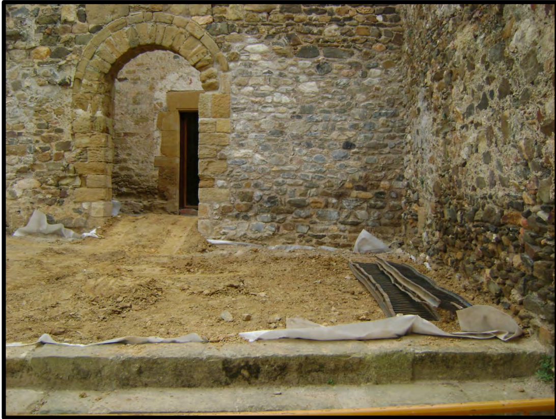
FOTO 7.- Finalització cobertura estructures entrada monestir
