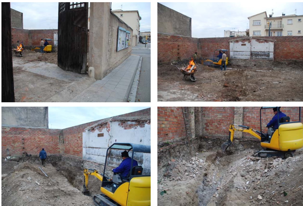
Fig. 3. Vista general dels treballs de realització de la rasa a l'interior del pati de la parcel.la prospectada.
