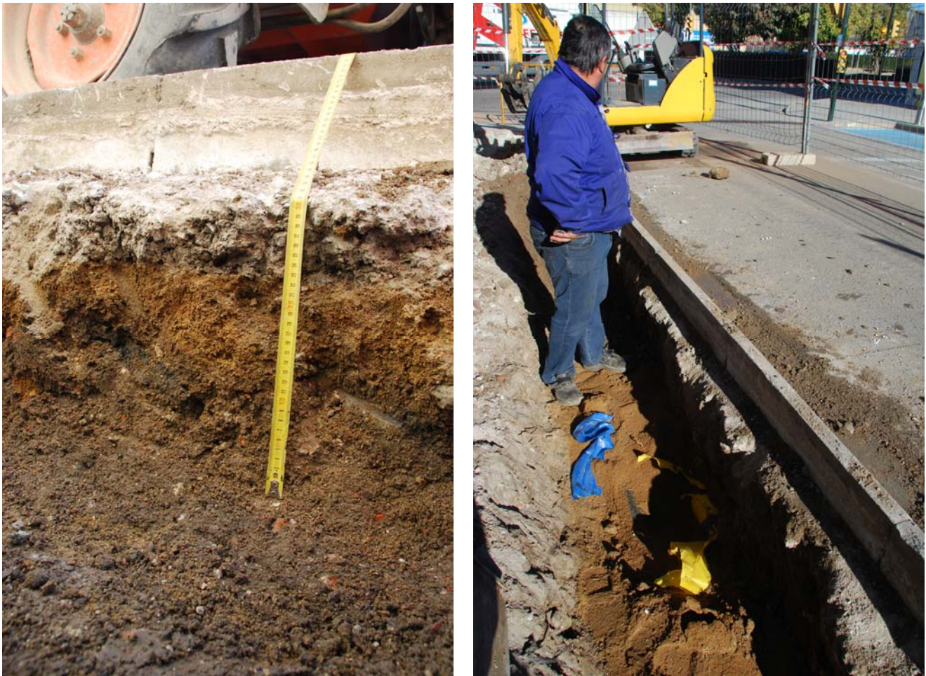
Fig. 7. Tall estratigràfic de la rasa oberta a la vorera esquerra del C/ Vall-llobera (esquerra) i detall de les senyalitzacions de control del pas de canalitzacions d'aigua i gas en el transcurs de la rasa realitzada.
