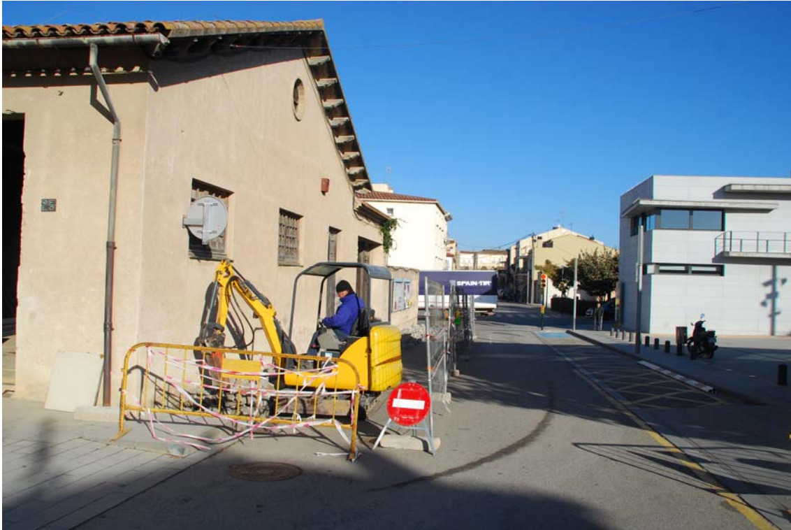
Fig. 5. Vista general dels treballs d'aixecament de la vorera esquerra del C/ Vall-llobera en contacte amb l'edifici que serà enderrocat.
