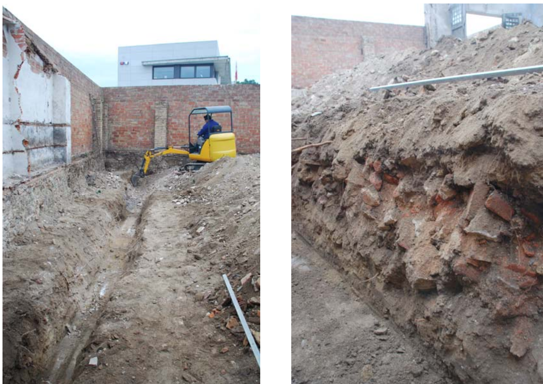
Fig. 4. Vista general de la rasa (esquerra) i detall del tall estratigràfic de la rasa realitzada (dreta).
