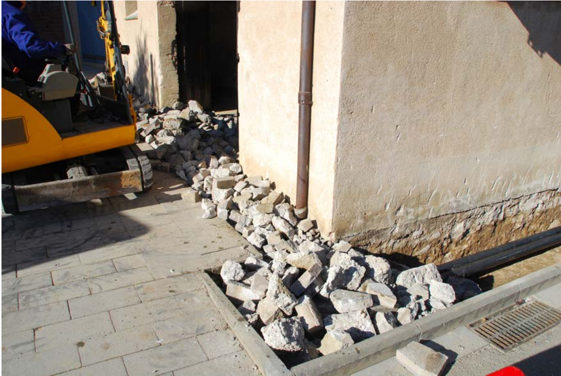
Fig. 8. Vista dels treballs d'aixecament del paviment de l'extrem sud de l'edifici i la obertura de la rasa de serveis.
