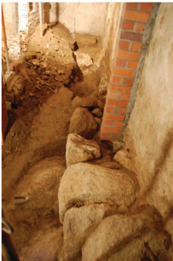
Blocs del mur des del safareig
