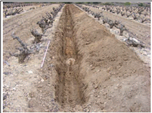
Foto 37: Rasa 6 ja realitzada.
