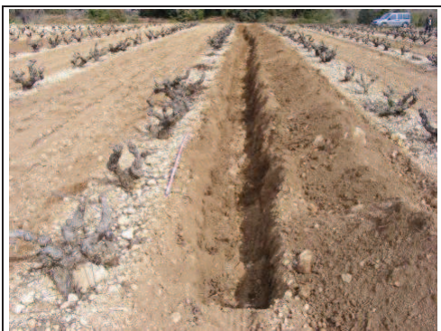
Foto 25: Rasa 4 ja realitzada.
