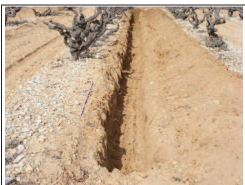
Foto 80: Rasa 13 ja realitzada.
