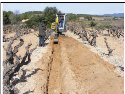
Foto 72: Rasa 12, procés d'excavació.
