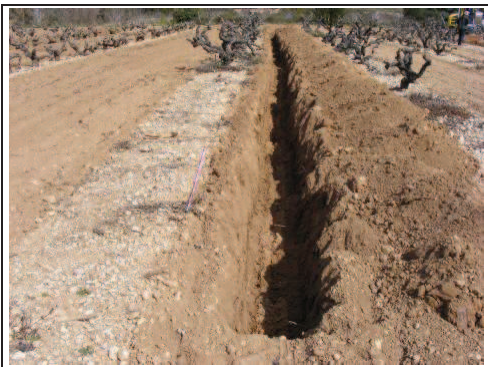
Foto 61: Rasa 10 ja realitzada.
