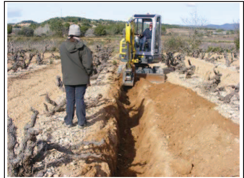
Foto 91: Rasa 15, procés d'excavació.
