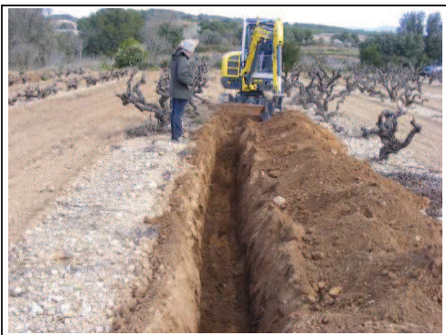
Foto 60: Rasa 10, procés d'excavació.
