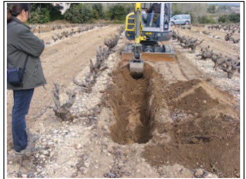
Foto 30: Rasa 5, procés d'excavació.
