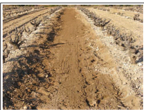
Foto 16: Rasa 2, un cop colmatada.
