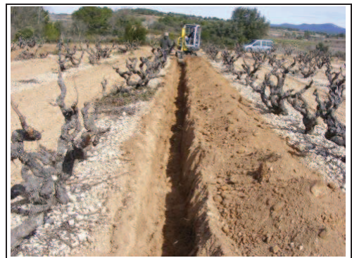
Foto 66: Rasa 11, procés d'excavació.
