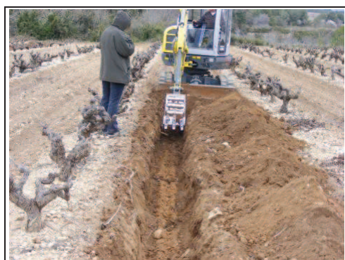
Foto 42: Rasa 7, procés d'excavació.
