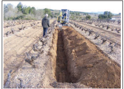
Foto 54: Rasa 9, procés d'excavació.
