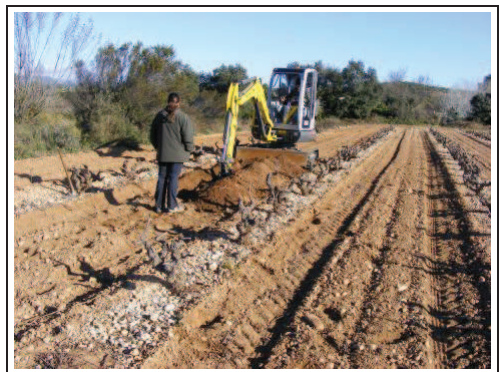
Foto 6: Rasa 1, procés d'excavació.
