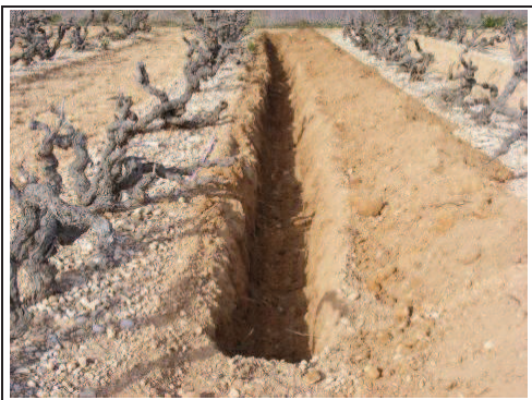
Foto 92: Rasa 15 ja realitzada.
