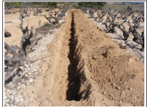
Foto 67: Rasa 11 ja realitzada.
