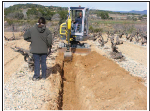
Foto 79: Rasa 13, procés d'excavació.
