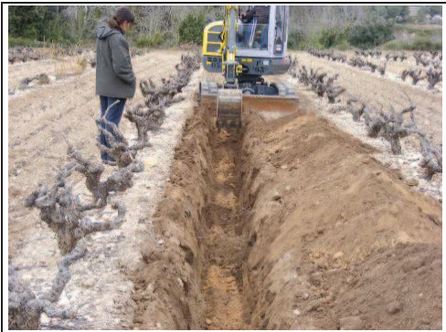
Foto 36: Rasa 6, procés d'excavació.
