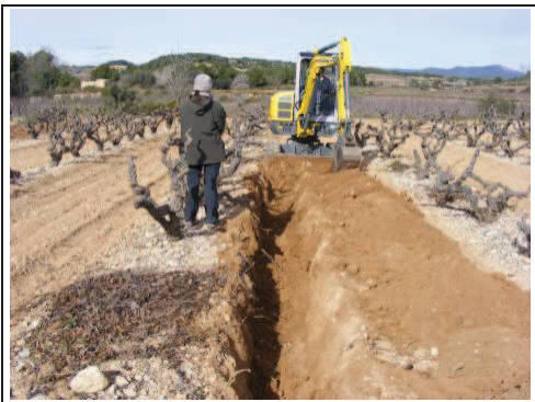
Foto 85: Rasa 14, procés d'excavació.
