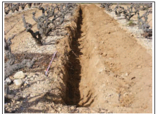
Foto 86: Rasa 14 ja realitzada.
