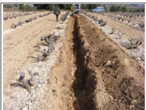
Foto 24: Rasa 4, procés d'excavació.
