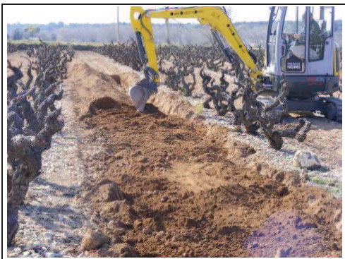
Foto 76: Rasa 12 , procés de colmatació.
