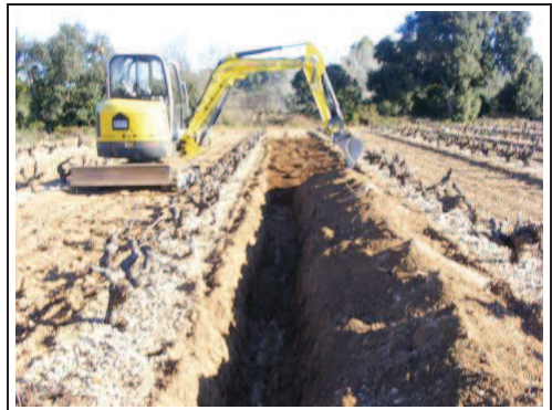
Foto 15: Rasa 2, procés de colmatació.
