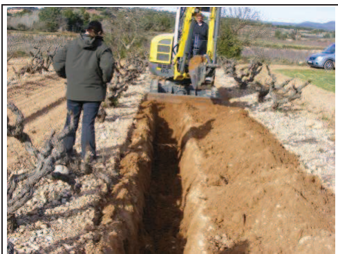
Foto 97: Rasa 16, procés d'excavació.
