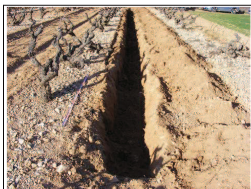
Foto 98: Rasa 16 ja realitzada.
