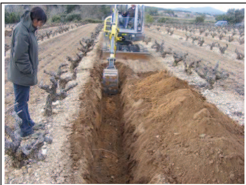
Foto 48: Rasa 8, procés d'excavació.
