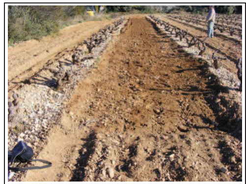
Foto 10: Rasa 1, un cop colmatada.
