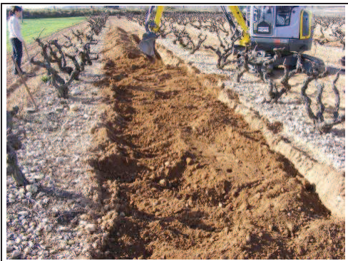
Foto 101: Rasa 16, procés de colmatació.
