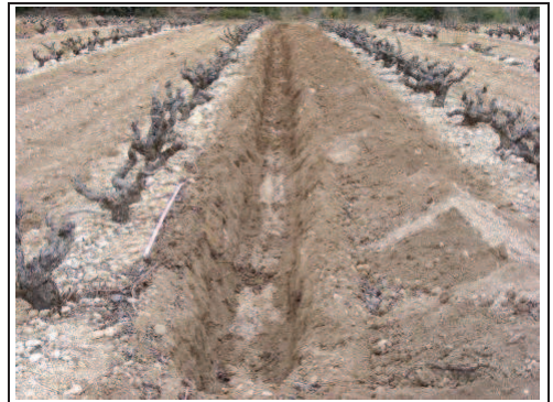
Foto 31: Rasa 5 ja realitzada.
