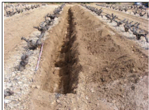
Foto 19: Rasa 3 ja realitzada.
