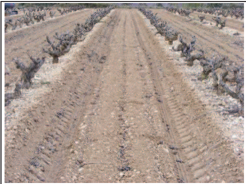
Foto 53: Rasa 9, zona abans de començar els rebaixos.
