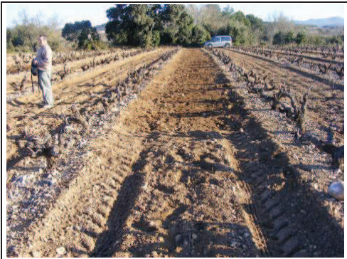
Foto 28: Rasa 4, un cop colmatada.
