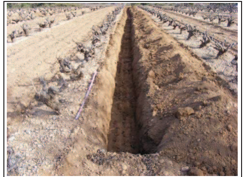
Foto 55: Rasa 9 ja realitzada.
