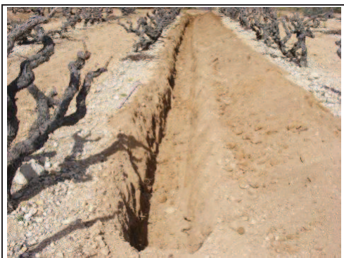
Foto 73: Rasa 12 ja realitzada.
