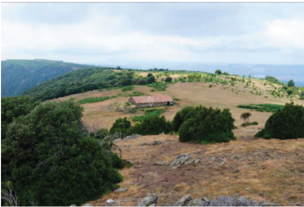
Figura 63: Vista general del corral i el replà on es troben les estructures.
