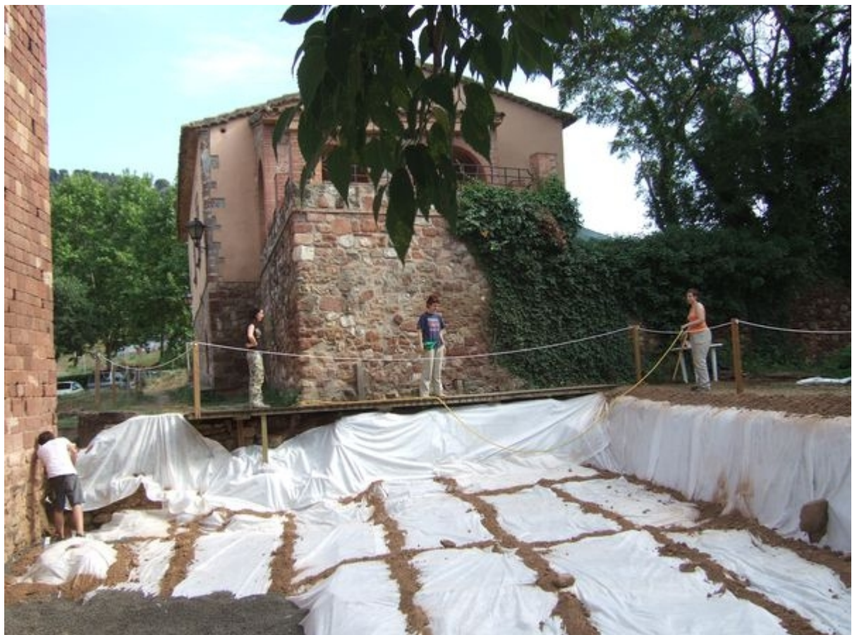
Treballs de protecció del jaciment amb geotèxtil al final de la campanya.
