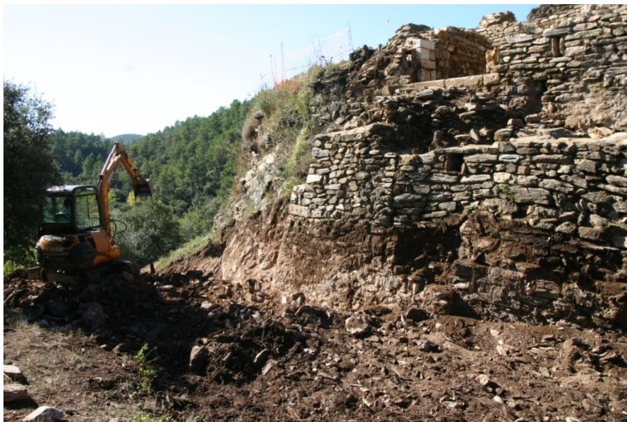
25. Procés de rebaix de l'estrat d'enderroc del fossat amb màquina excavadora.
