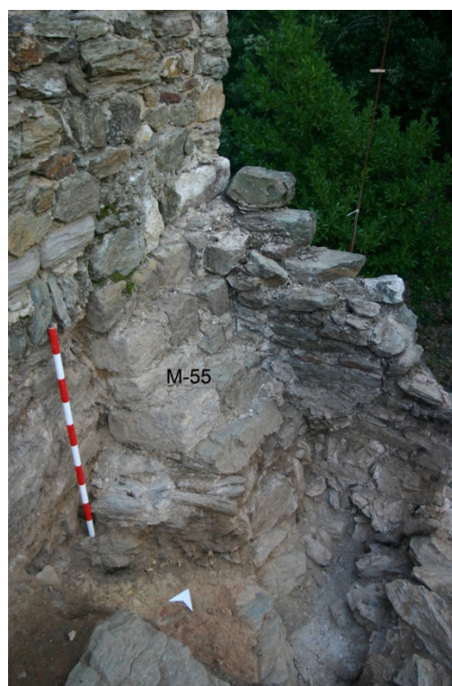
11. Detall del contrafort M-55 situat al sector 9.
