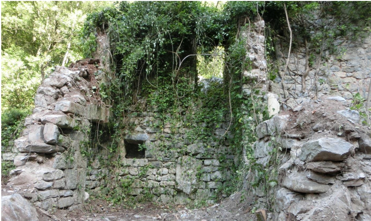
Figura 12. Mur UE1001 al fons i la part conservada dels murs oest-est UE1016 i UE1023. L'espai delimitat correspon a l'àmbit 2. Podem observar-hi la porta UE1004 que dona la feixa superior de ponent i l'enfony UE1020.
