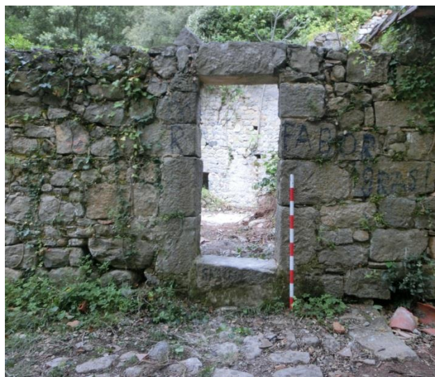
Figura 19. Porta UE1006. Accés des de l'exterior est, vist des de l'est
