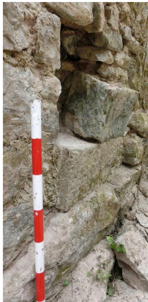
Figura 14. Detall de l'arrencament d'arcada UE1013 en el parament del mur UE1016
