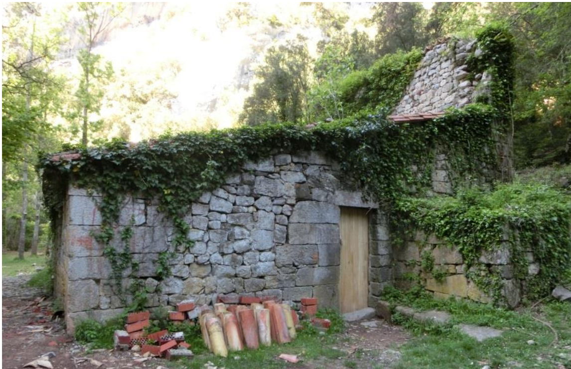
Figura 7. Aspecte actual de la façana nord.
