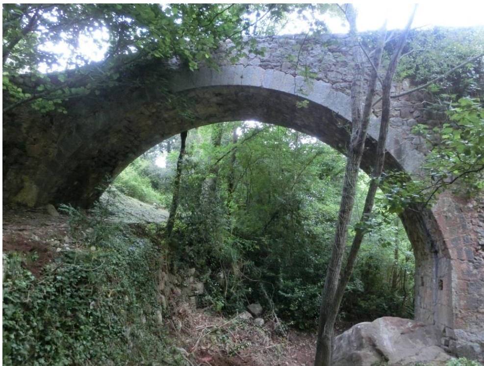
Figura 3. L'accés des del camí de Sant Aniol travessa el pont de Valentí
