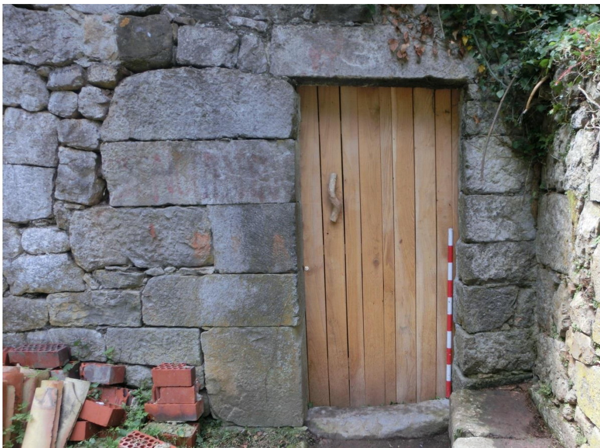
Figura 17. Porta UE1005 oberta a la façana nord.
