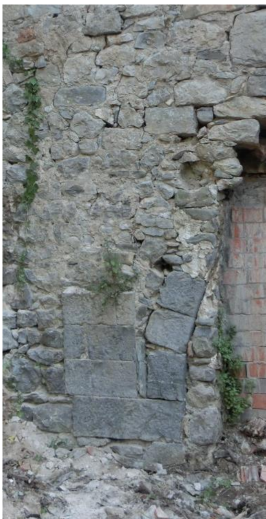
Figura 13. Modificacions en el parament del mur UE1018, amb l'arrencament d'arcada UE1014.
