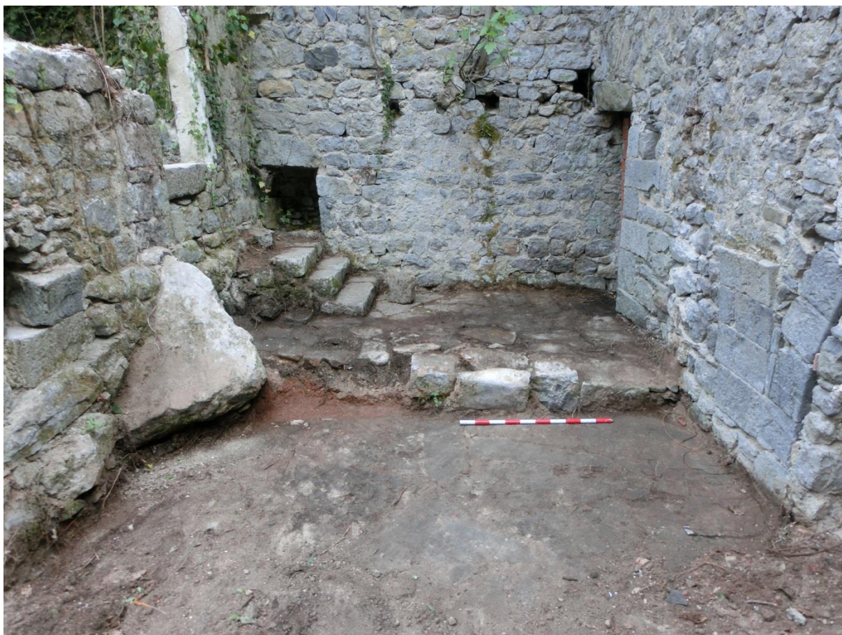
Figura 23. Paviments de l'àmbit 1 i esglaó cap a ponent
