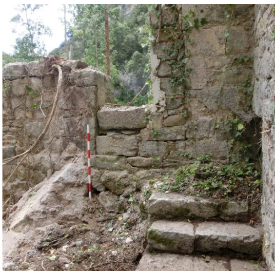
Figura 20. Porta UE1011, l'escala UE1012 i el tapiat parcial UE1018. Vista des del nord
