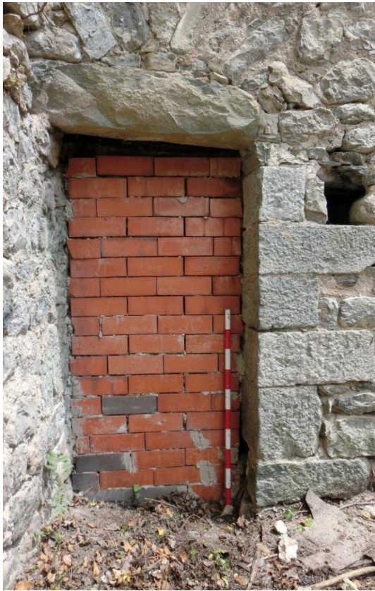
Figura 15. Porta UE1010 oberta en el mur UE1018, vist des del sud.
