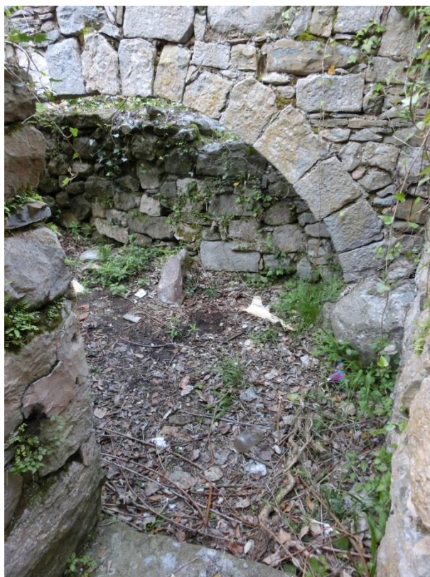
Figura 8. Aspecte d'un dels espais interiors enrunats abans de la intervenció de seguiment.
