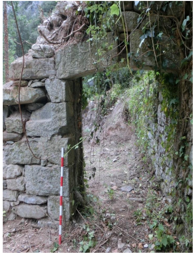
Figura 16. Porta UE1022 oberta en el mur UE1023, vist des del nord.
