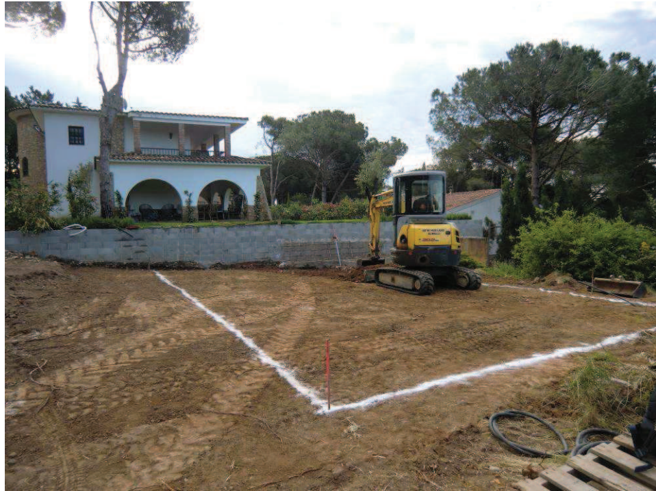
Fig. 3. Limits de la piscina marcats i inici dels rebaixos.
