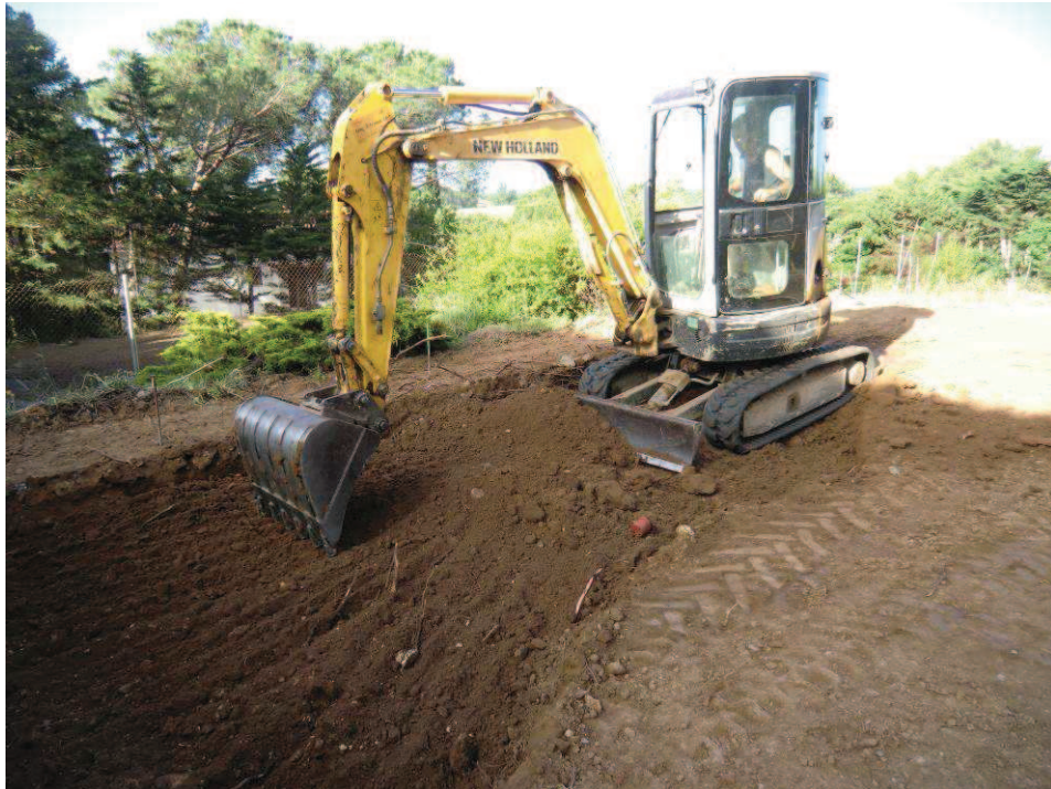
Fig. 4. Rebaixos menys profunds del costat est.
