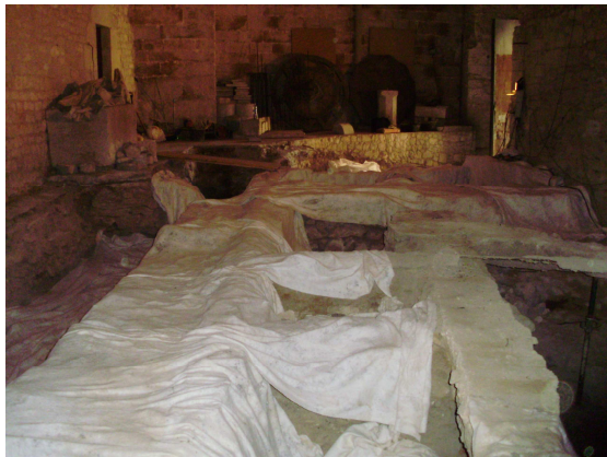
Col·locació geotèxtils com elements protecció
