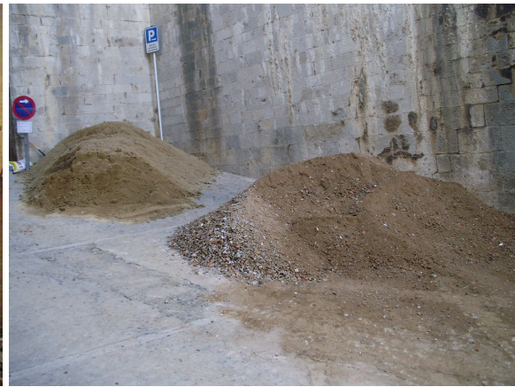
Tasques de rebliment i col·locació de la capa de circulació de sauló. A la darrera imatge tipus de material emprat (terra reciclada i sauló (al fons)).
