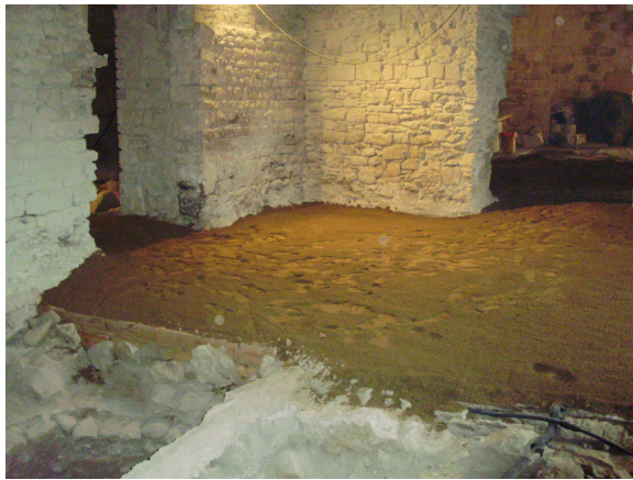
Tasques de rebliment i col·locació de la capa de circulació de sauló. A la darrera imatge tipus de material emprat (terra reciclada i sauló (al fons)).
