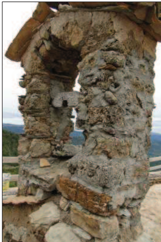
Detall del campanar amb és de pedres tosques reaprofitades en la seva construcció.
