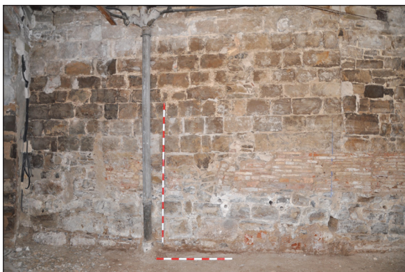
Figura 6. Tram de la muralla més proper al desaparegut portal de Falcó o del Carme, que presenta una factura més acurada i més ben conservada que la resta. Fotografia: Oriol Saula (MCUT).
