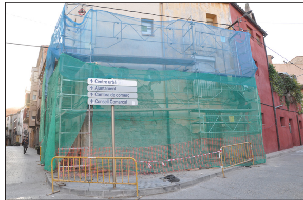
Figura 17. Repicat de l'arrebossat modern de les cares oest i nord de la torre de la banda esquerra del portal d'Urgell. Fotografia: Oriol Saula (MCUT).
