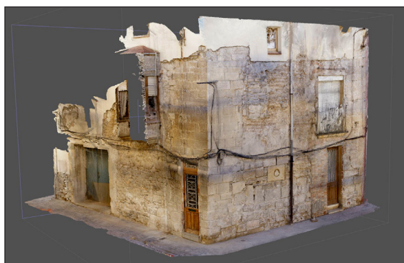
Figura 22. Model 3D de la torre amb la bastida esborrada de la imatge original. Imatge: Josep Giribet.
