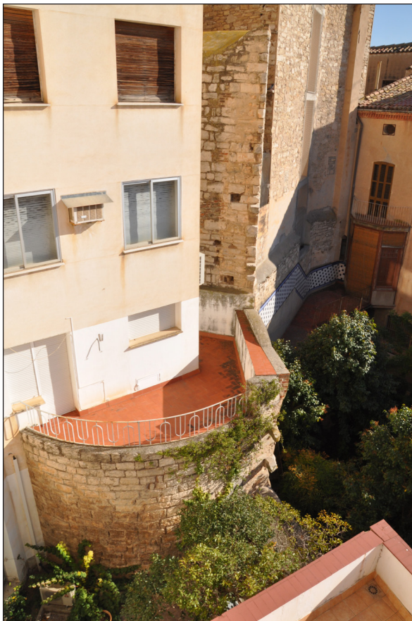
Figura 7. Restes de la torre semicircular de l'antic Banc Popular que estava situada a l'angle de la muralla que ve de la plaça del Carme i d'aquí baixa per darrera de les cases de l'avinguda de Catalunya en direcció oest. Fotografia: Oriol Saula (MCUT).
