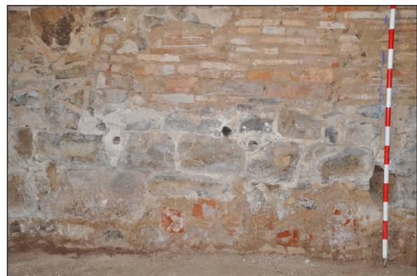
Figura 8. Detall dels forats per inserir-hi pals de fusta per lligar-hi èquids. Per damunt, la reparació feta amb maó per tapar els forats de les bigues del sostre desaparegut. Fotografia: Oriol Saula (MCUT).
