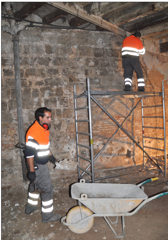
Figura 3. Repicat controlat de l'arrebossat de la muralla per part de la Brigada Municipal de Tàrraga amb la supervisió dels arqueòlegs del museu. Fotografia: Oriol Saula (MCUT).
