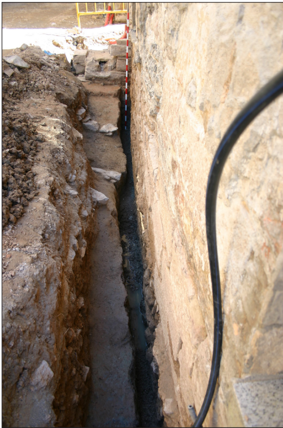
Figura 14. Rasa de fonamentació del mur UE 1022 de la torre del segle XIV, de la banda esquerra del portal. Fotografia: Anna Colet (MCUT).
