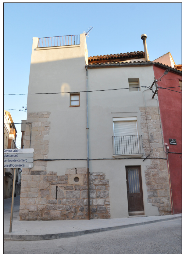
Figura 26. Torre esquerra del portal d'Urgell un cop finalitzada l'actuació de restauració i adequació.
