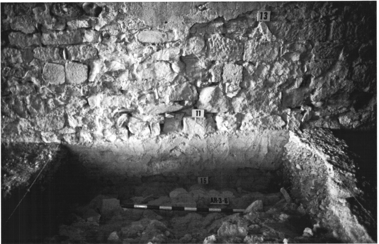
AR3-13 i 15: arrebossats AR3-11: mur
