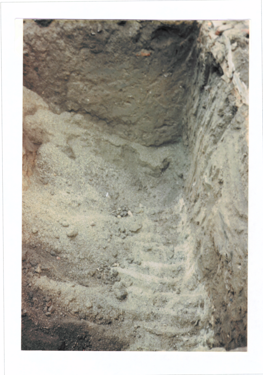
Vista d'una de les rases de fonamentació realitzades per a la construcció d'una nova casa al solar del carrer Agulló núm. 22.
