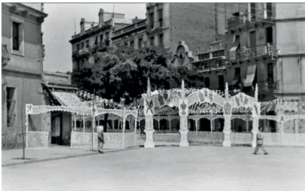
Portalada de tres arcs decorada amb naips de la baralla espanyola i llotges construïdes amb una estructura de gelosies al carrer de la Independència del Clot. Fons: Taller d'Història del Clot - Camp de l'Arpa.
