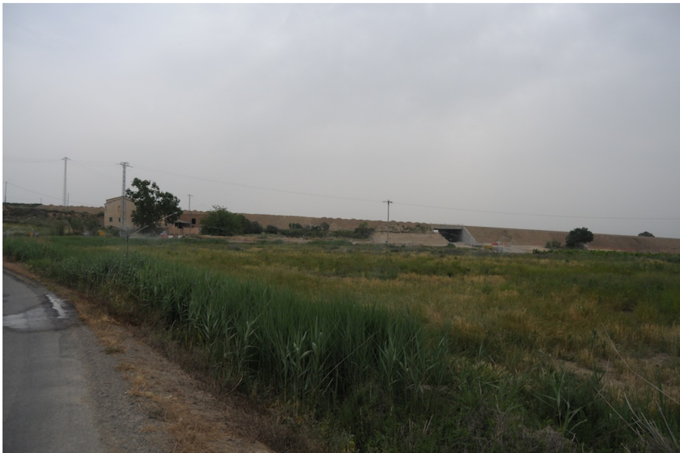
Fig. 3. Vista de la partida del Pla de Montsó (Alpicat) al fons les obres de la A-14
