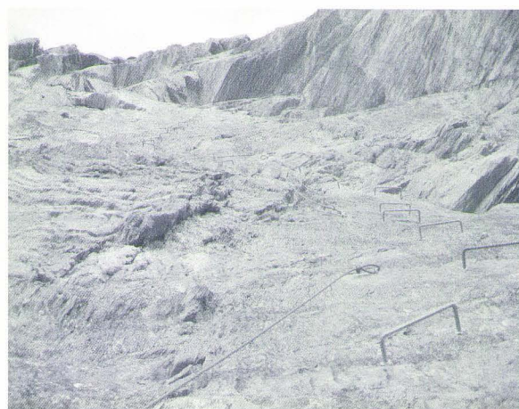
Tram vertical amb desplom a la ferrada del Roc del Quer
