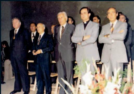
A la Diada de Meritxell, en les obres del nou santuari
