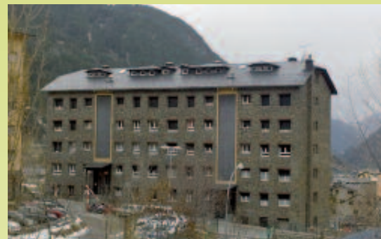
Edifici Solixent a Encamp, on residia
