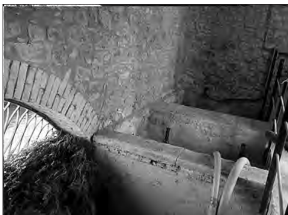
Interior de la caseta; a l'esquerra el sobreixidor; al mig l'arqueta on se situava el flotador, al fons l'arqueta on se situava la canonada de descàrrega, juny 2016. Fundació Aigües de Manresa i Junta de la Sèquia.
