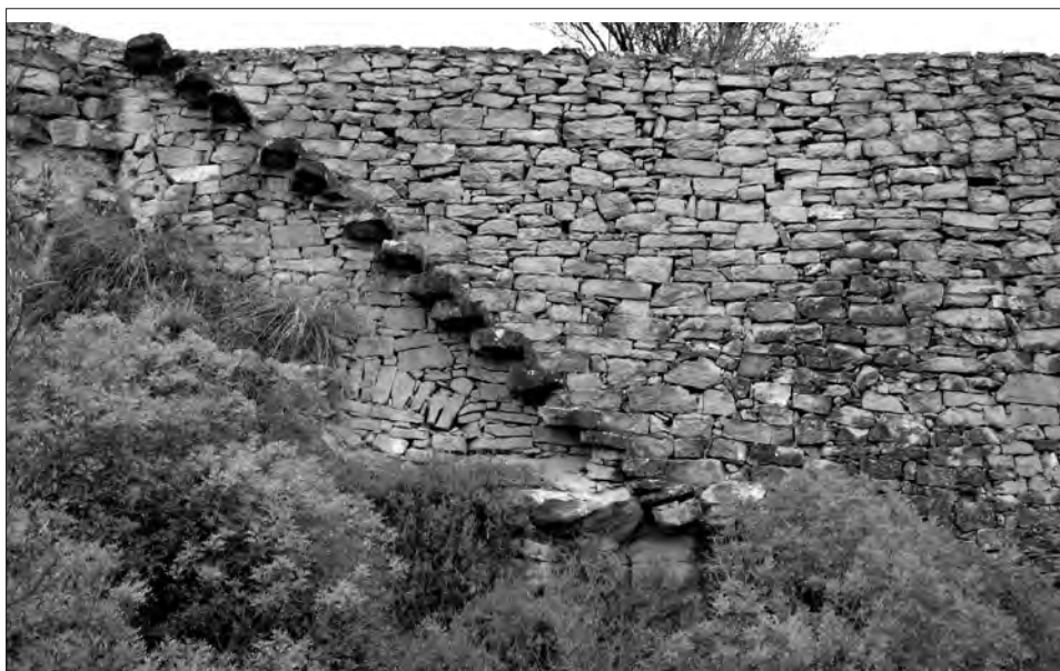
Marge amb escales de pedra seca de la zona de can Poc Oli.
