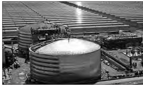
Central termosolar Andasol 3, Guadix, Granada.
