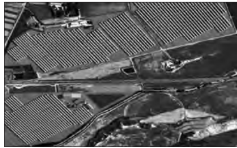
Central termosolar de les Borges Blanques.
