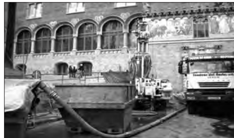
Treballs per al sistema geotèrmic a l'Hospital de Sant Pau, Barcelona.
