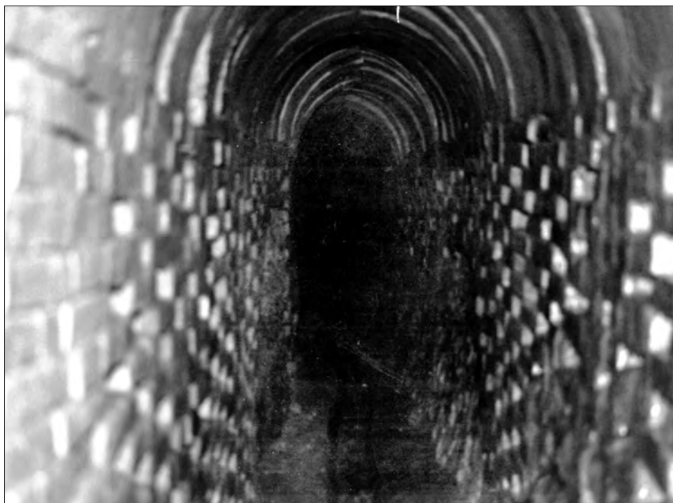
Figura 2. Imatge de la mina de can Tries. La tipologia habitual és la de paret de maó —en aquest cas en forma de xarxa per permetre que l'aigua vessi de les parets— i volta de canó feta amb dues peces de terra cuita. L'aigua circulava pel canal central del sòl i els sòcols laterals servien perquè els minaires la recorreguessin sense mullar-se. Foto: Angel Losada.
