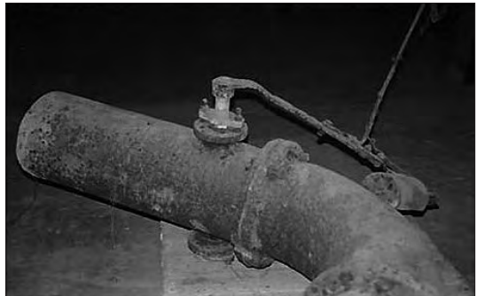
Accionament de la vàlvula circular en la canonada de descàrrega a l'arribada al Museu de la Tècnica de Manresa. Font: Fundació Aigües de Manresa i Junta de la Sèquia.
