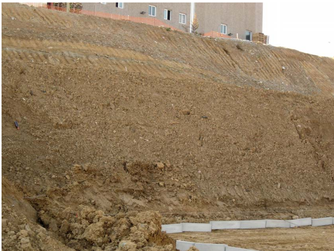
Punt 1. A la fotografia s'aprecien dos nivells. En el primer nivell, situat a la banda dreta de la part alta de la imatge, s'observa la flexió del bloc superior (ganxo de falla). Aquesta geometria de la flexió, i el corresponent abombament del bloc superior, ens permetrien suposar una certa entitat a aquesta falla. En el nivell inferior es veu el talús ja cobert amb la terra vegetal.
