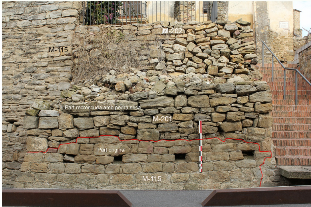
1. Vista general de la façana sud-oest de la muralla d'Ullastret.
