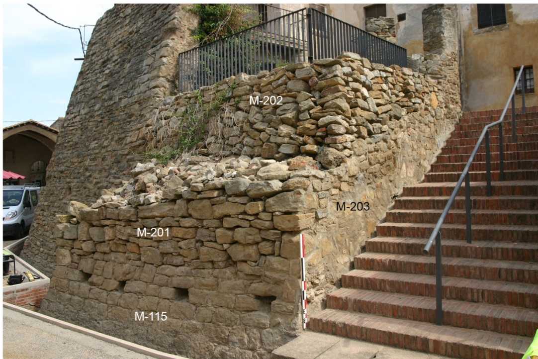
2. Detall de l'angle sud del recinte fortificat.
